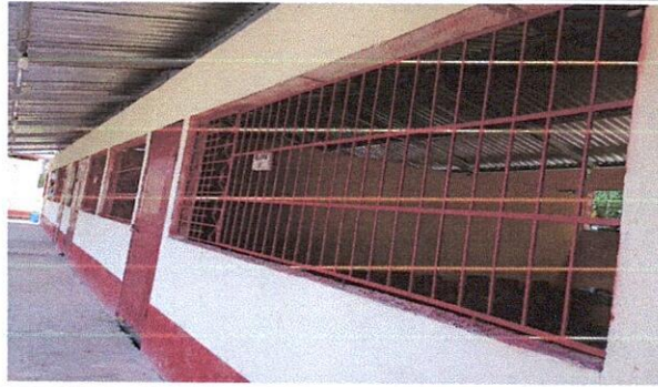
Foto 7: Sustitución de balcones de metal
