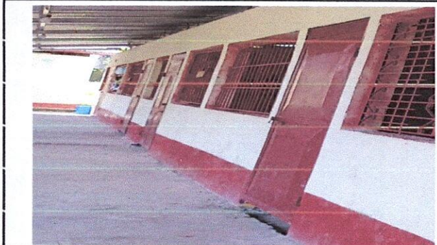
Foto 2: Sustitución de puerta
