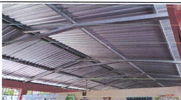
Foto 6: Sustrucción de estructura de soporte de madera, por metal
