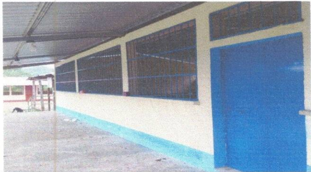
Foto 2: FABRICACION E INSTALACION DE VENTANAS DE BALCON
