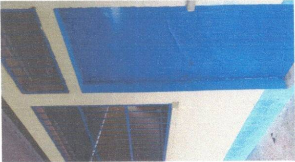
Foto 3: Fabricacion e instalación de puerta de metal
