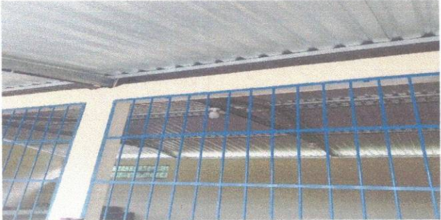
Foto1: SUSTITUCION DE LAMINA POR LAMINA TROQUELADA
