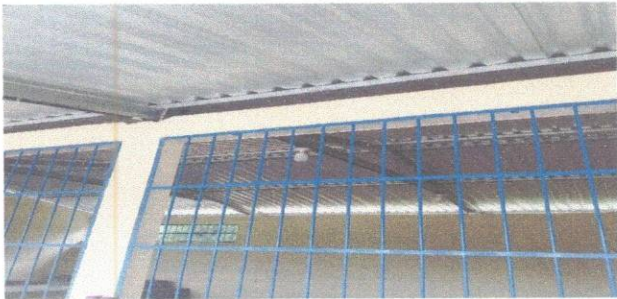
Foto 6: Sustitucion de lamparas
