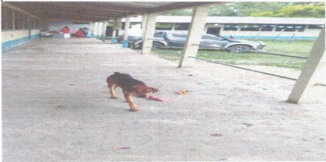
Foto 9: LOSA DE PATIO
