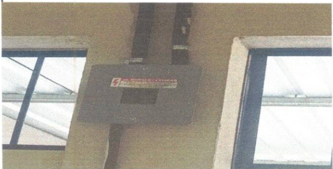
Foto 4: SUSTITUCIÓN DE DUCTOS MAS ACCESORIOS
