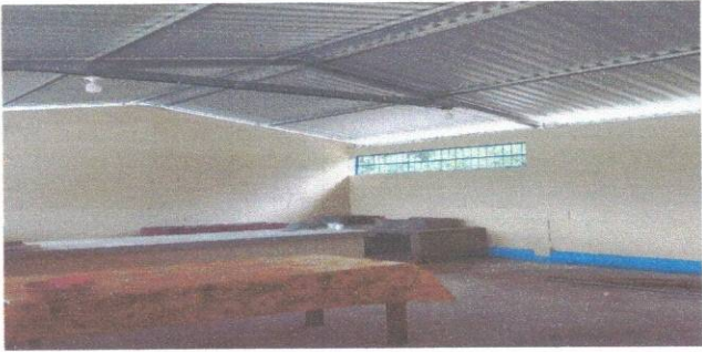
Foto 5: reparación de repelloy cernido de pared
