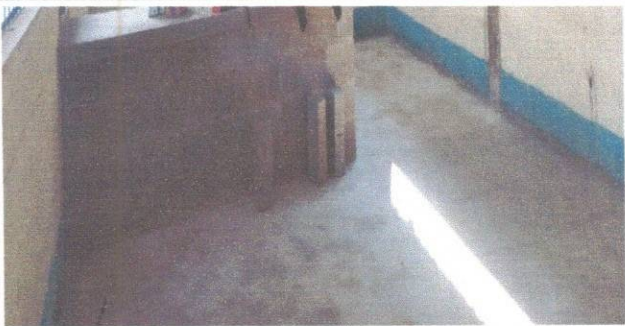
Foto 4: reparacion de piso de cemento liquido
