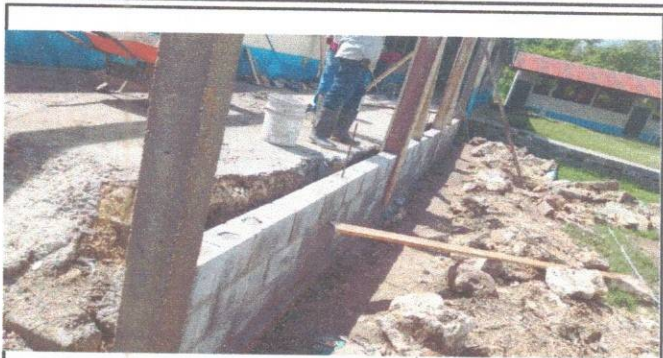
Foto 8: REPARACION DE MUROS DE CONTENSION
