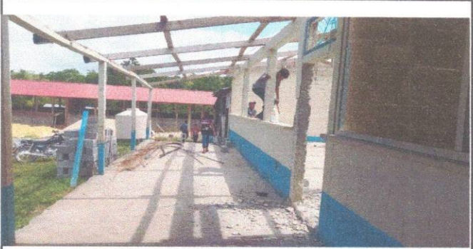
Foto 3: FABRICACION E INSTALACION DE PUERTA DE METAL
