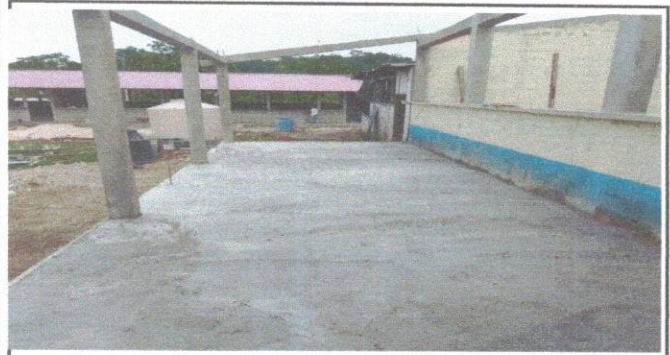
Foto 9: LOSA DE PATIO
