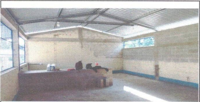
Foto 5: REPARACCION DE REPELLO Y CERNIDOS DE PARED
