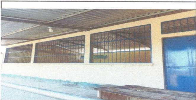
Foto 6: SUSTITUCION DE LAMPARAS
