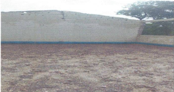
Foto 4: REPARACION DE PISO DE CEMENTO LIQUIDO
