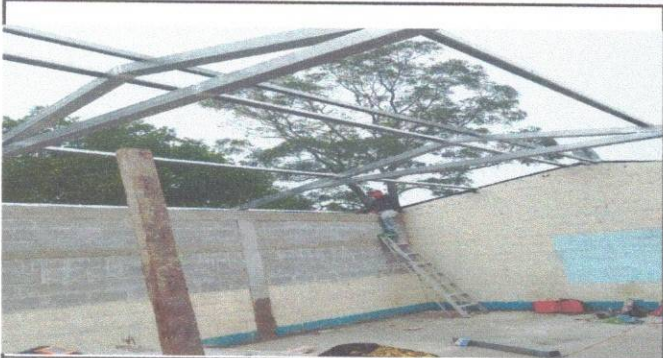
Foto1: SUSTITUCION DE LAMINA POR LAMINA TROQUELADA
