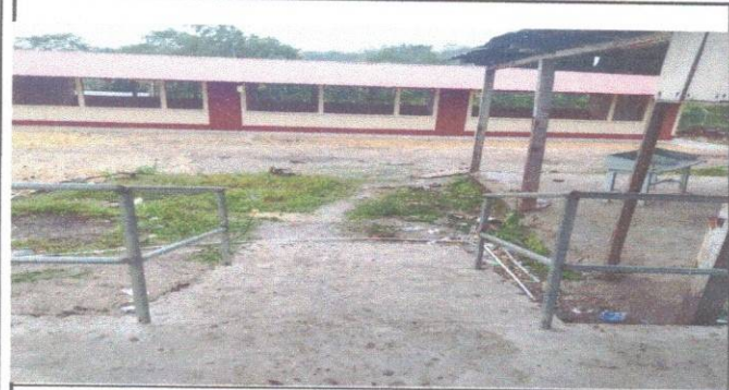
Foto7: RED DE AGUA POTABLE
