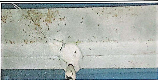
Foto 4: Sustitucion e instalacion de plafoneras
