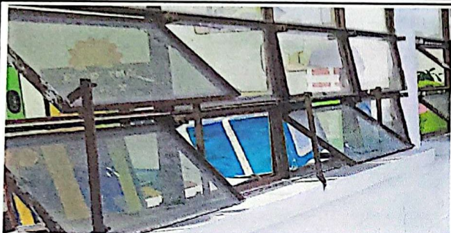
Foto1: Fabricacion e instalacion de balcones de ventana
