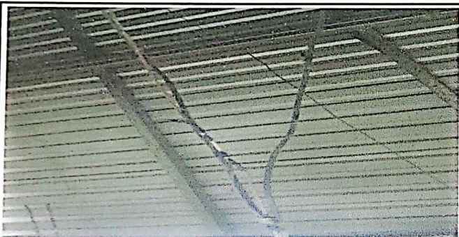
Foto 3: sustitucion e instalacion de sistema electrico principal
