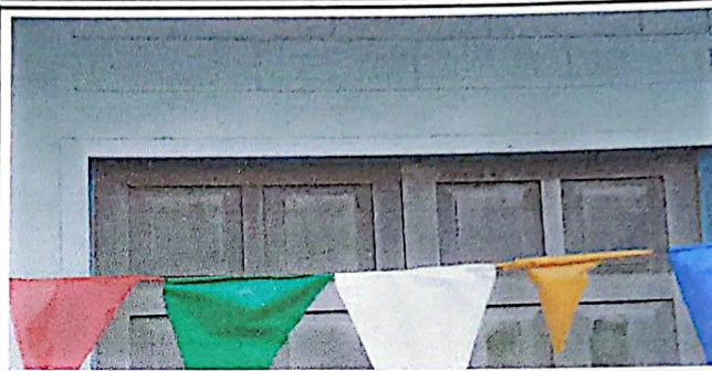
Foto 2: sustitucion de ventana de madera por metal
