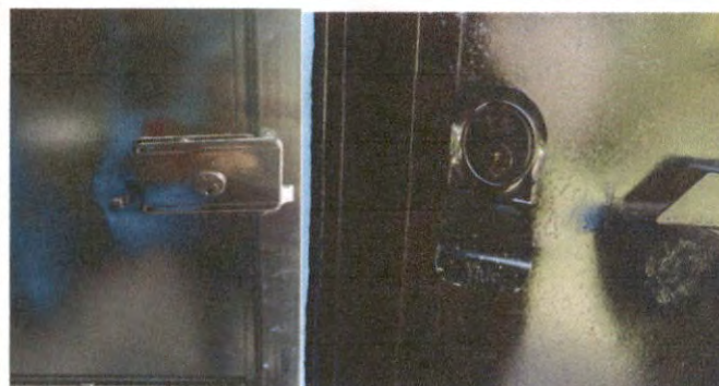
SUSTITUCION DE CHAPAS
