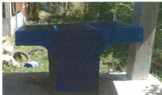
SUSTITUCIÓN DE PILA DE CONCRETO DE DOS LAVADEROS
