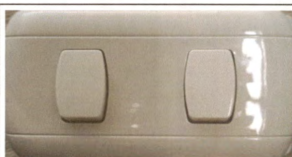
Foto 12: sustitucion de interruptores
