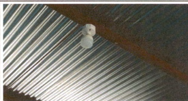
Foto 10: sustitucion de focos ahorradores
