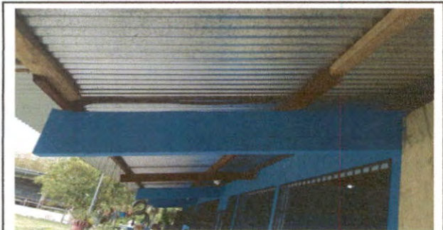
Foto 9: Reparación de Sistema Eléctrico
