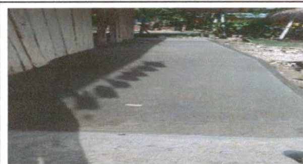
Foto 8: Reparacion de plancha de concreto de patio
