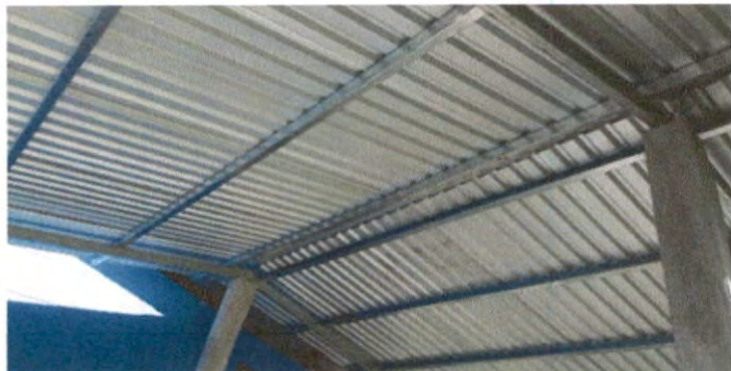
foto 1.1 SUTITUCIÓN DE LÁMINA TROQUELADA ALUZINC CALIBRE 26
