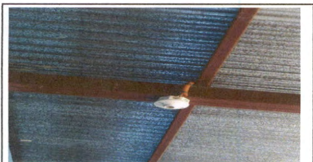
Foto 11: sustitución de plajoneras
