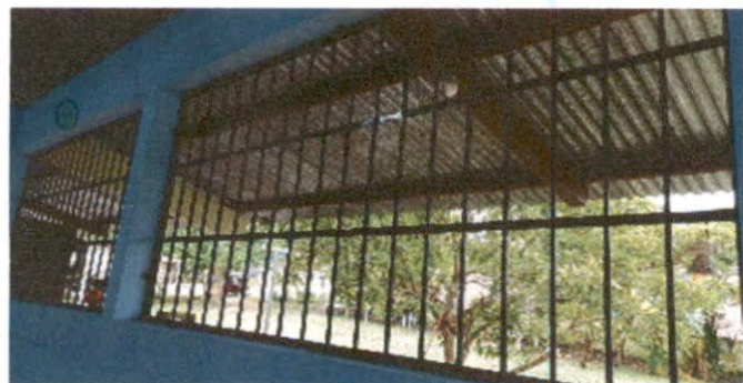
MANTENIMIENTO A BALCONES DE METAL
