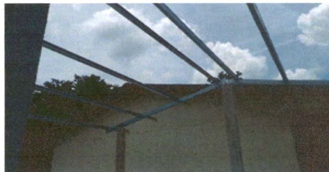
SUSTITUCION DE SOPORTE DE METAL POR METAL
