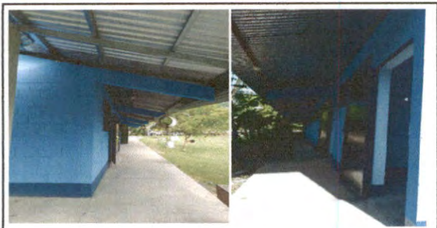
Foto 7: pintura de muros exteriores e interiores
