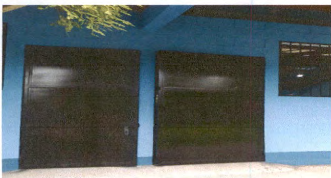
MANTENIMIENTO DE ESTRUCTURA DE METAL (LIJADO, CAMBIO DE TUBO, CEPILLADO, SUJECIONES, APLICACIÓN DE PINTURA)
