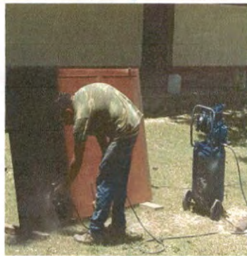
MANTENIMIENTO DE ESTRUCTURA DE PUERTA DE METAL (LIJADO, CAMBIO DE TUBO, CEPILLADO, SUJECIONES, APLICACIÓN DE PINTURA)
