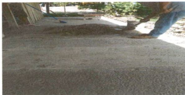
Reparacion de plancha de concreto de patio
