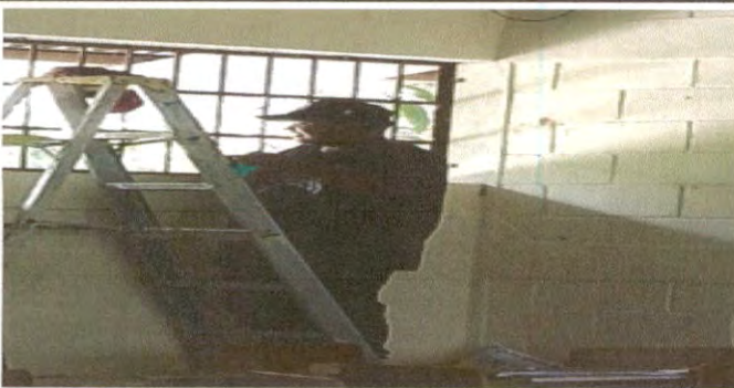
MANTENIMIENTO A BALCONES DE METAL
