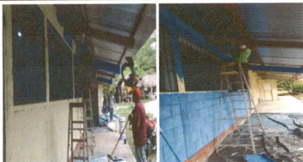
pintura de muros exteriores e interiores
