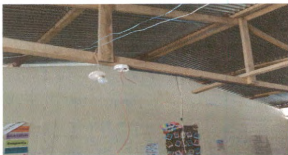
Reparación de Sistema Eléctrico
