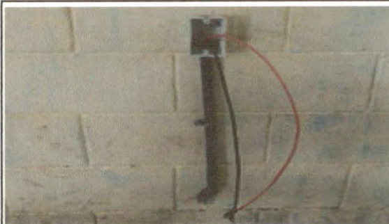
Sustitucion de interruptores
