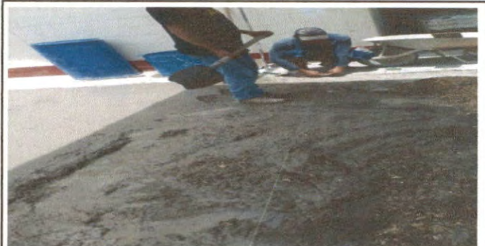
REPACIÓN DE PISO DE TORTA DE CONCRETO
