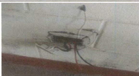
SUSTITUCION DE TOMACORRIENTES
