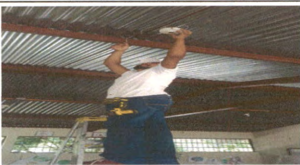
Sustitución de plajoneras
