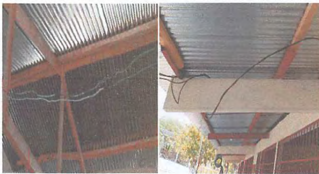
REPARACIÓN DE CABLEADO ELECTRICO
