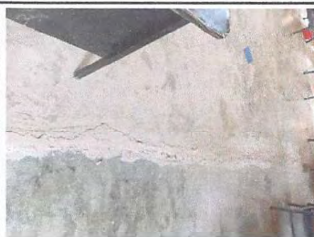
REPARACIÓN DE PISO DE TORTA DE CONCRETO
