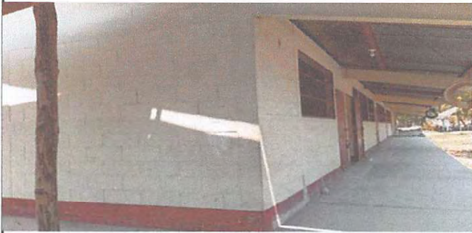
PINTURA EN MUROS EXTERIORES E INTERIORES
