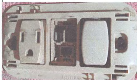
SUSTITUCIÓN DE INTERRUPTORES
