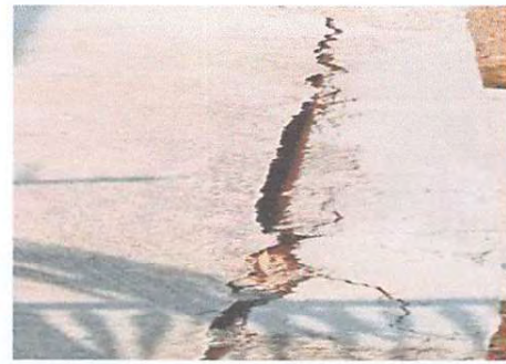
REPARACIÓN DE PLANCHA DE CONCRETO DE PATIO
