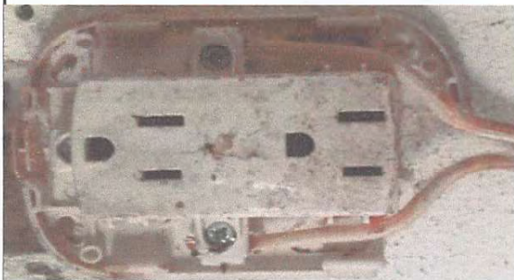
SUSTITUCIÓN DE TOMACORRIENTES
