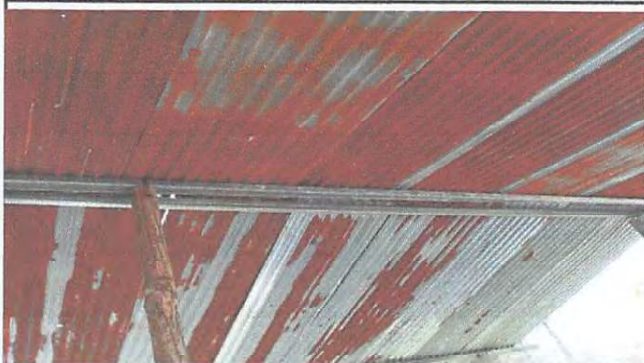
1.1.SUSTITUCIÓN DE LÁMINA, POR LÁMINA TROQUELADA ALUZINC CALIBRE 26
