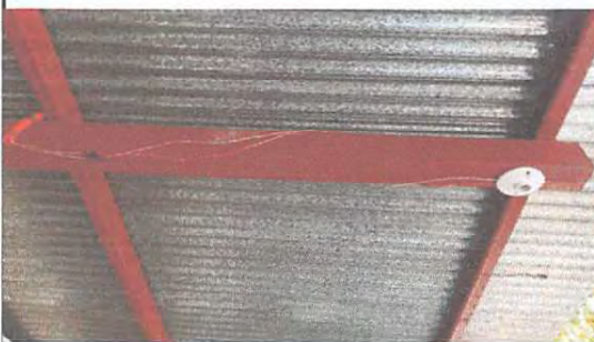
SUSTITUCIÓN DE PLAFONERAS
