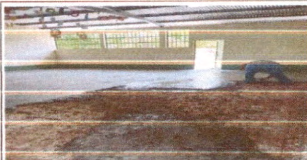
Sustitucion de piso de torta de concreto.
