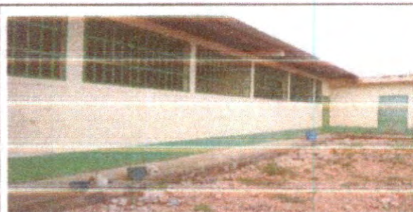
Pintura en muros exteriores e interiores
