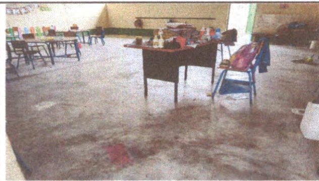
Sustitución de piso de torta de concreto
