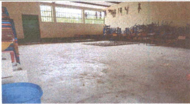
Sustitución de piso de torta de concreto
