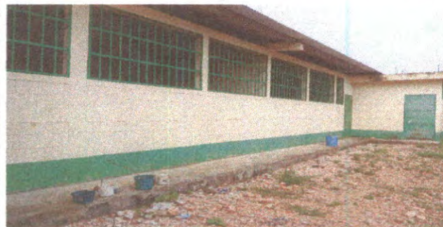
Pintura en muros exteriores e interiores
