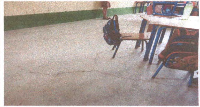
Sustitución de piso de torta de concreto
