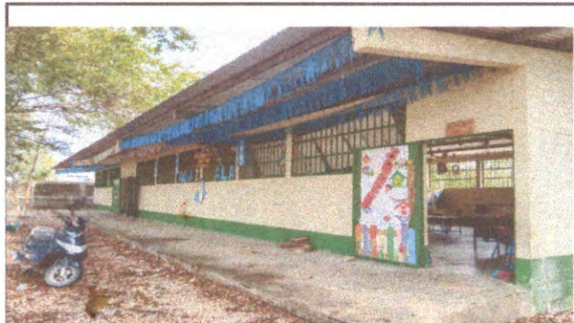
Pintura en muros exteriores e interiores
