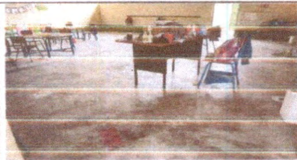
Sustitución de piso de torta de concreto
