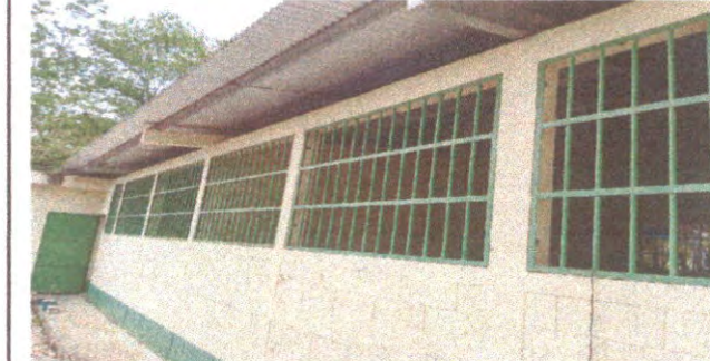
Pintura en muros exteriores e interiores
