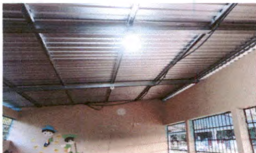
SUSTITUCIÓN DE DUCTO + ACCESORIOS
