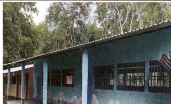
SUSTITUCIÓN DE ESTRUCTURA DE METAL DE VENTANA
