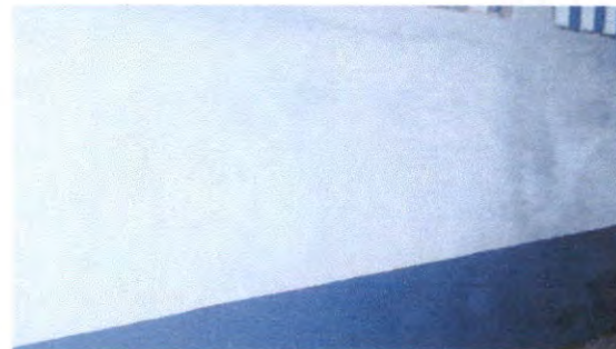
PINTURA EN MURO EXTERIOR E INTERIOR
