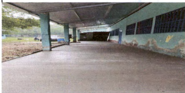
SUSTITUCIÓN DE TORTA DE CONCRETO
