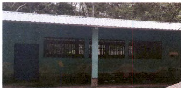
SUSTITUCIÓN DE PUERTA
