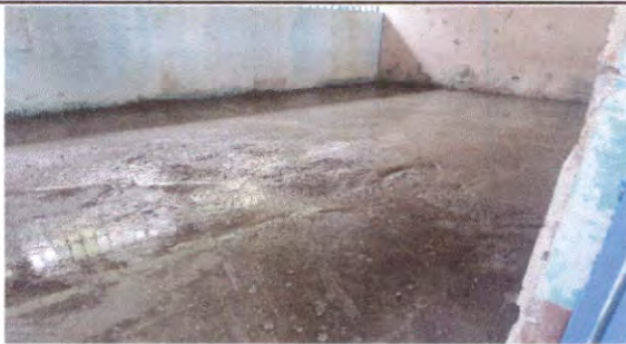
SUSTITUCIÓN DE TORTA DE CONCRETO
