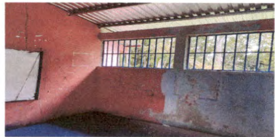
SUSTITUCIÓN DE BALCON DE METAL
