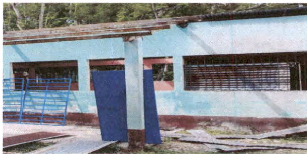
SUSTITUCIÓN DE PUERTA
