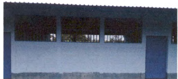
PINTURA EN MURO EXTERIOR E INTERIOR
