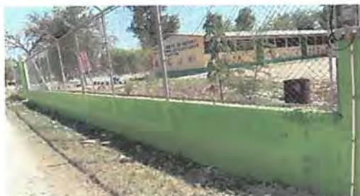
Foto1: 9.1 Pintura en muros exteriores e interiores
