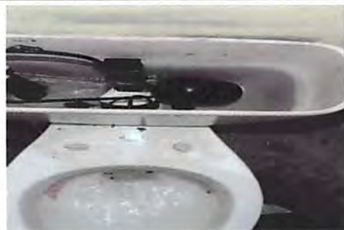
sustitucion de accesorios de inodoro
