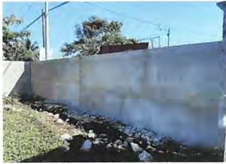
Foto 7: Reparación de muro perimetral
