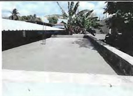
Foto 5: Impermeabilización de losa
