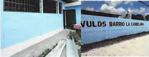
Foto 1: Pintura en muros exteriores e interiores
