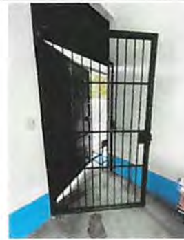
Foto 4: Fabricacion e instalacion de puertas de rejas.
