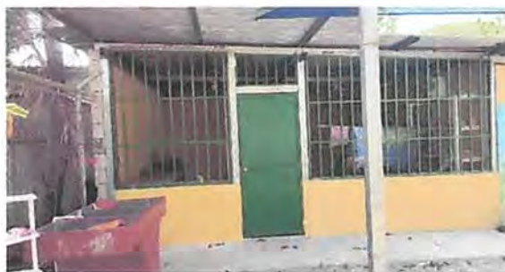
Foto 5: 4.3 sustitución de puerta
