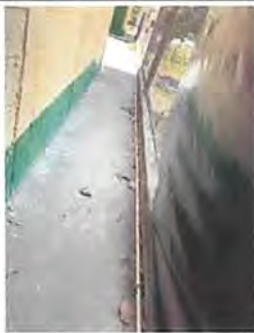
Foto 3: 14.9 sustitución de tubería línea principal.
