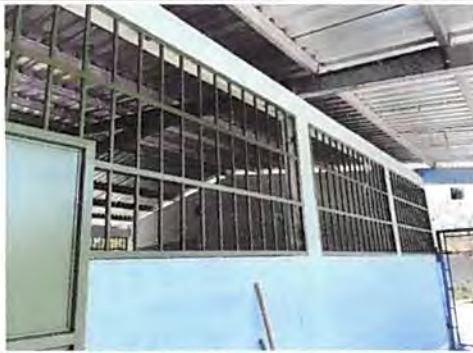
Foto 3: Mantenimiento de Balcones de Metal.
