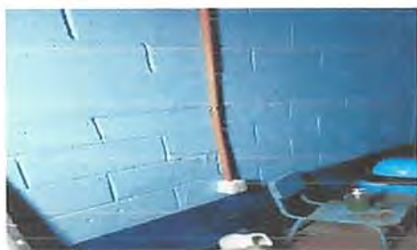
sustitucion de tomacorrientes dobles
