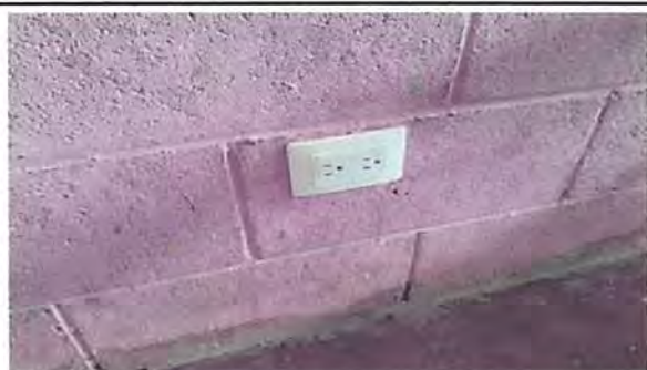
sustitucion de toma corrientes dobles
