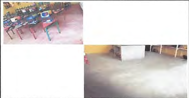
Foto 6: 6.1 reparación de piso de torta de concreto
