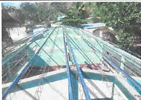
sustitucion de costaneras de metal por metal
