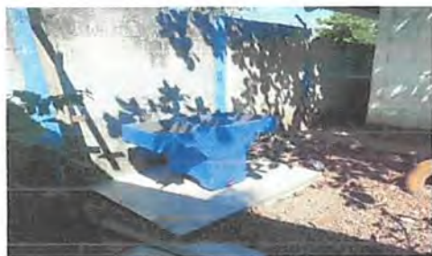
sustitucion de pila
