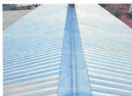
sustitucion de lamina acanalada por lamina troquelada con alisinc
