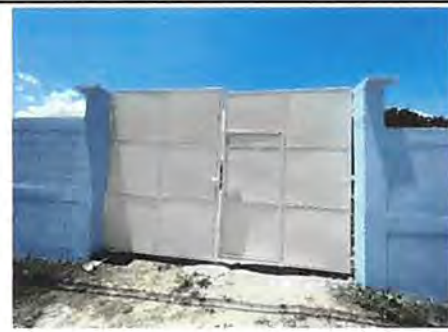
Foto 6: Mantenimiento de portones de metal
