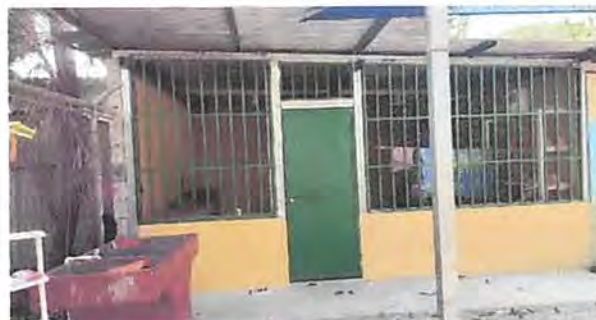
Foto 2: 5.6 sustitución de balcones de metal
