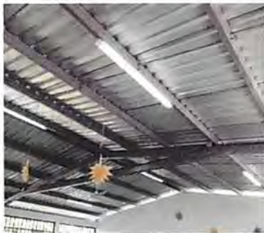
Foto 9: Sustitución de lámparas 2 X 40
