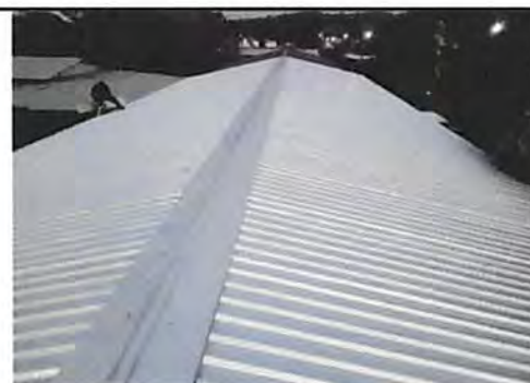
Sustitución de enlaminado.
