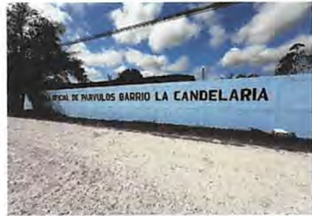
Foto 8: Pintura en Muros exteriores.
