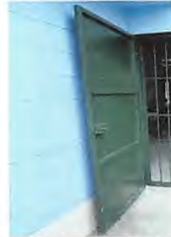
Foto 2: Mantenimiento de estructura de puertas de metal
