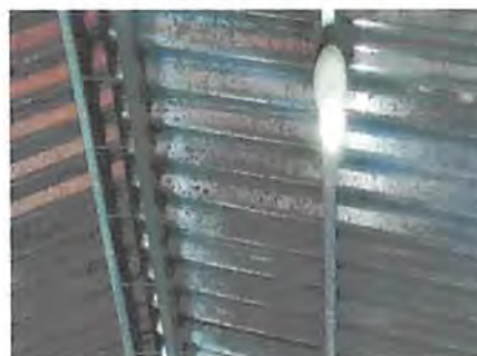
sustitucion de plafoneras
