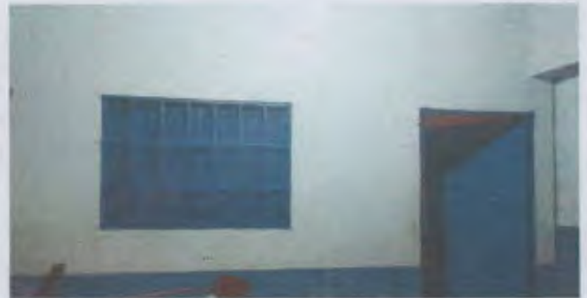
SUSTITUCIÓN DE VENTANA DE MADERA POR METAL MAS VIDRIO
