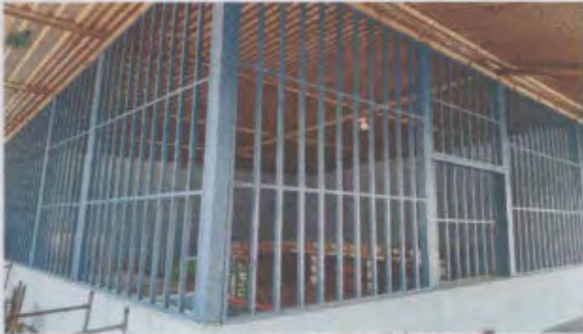
SUSTITUCIÓN DE BALCON DE METAL POR METAL
