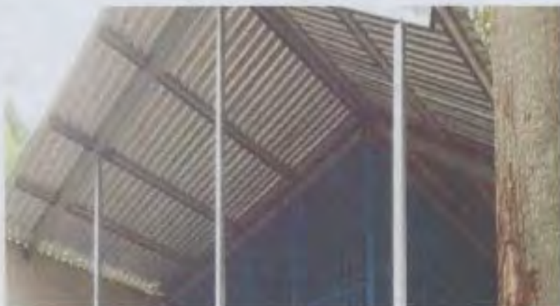
SUSTITUCIÓN DE LAMINA TROQUELADA ALUZINC CALIBRE 26
