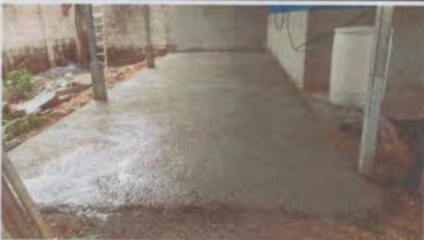
SUSTITUCION DE TORTA DE CONCRETO
