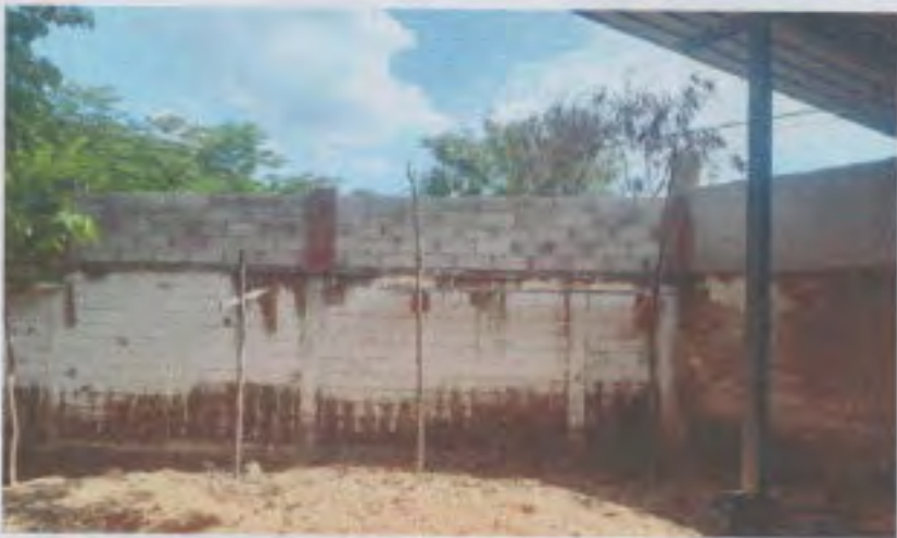
REPARACIÓN DE MURO PERIMETRAL MAS BLOCK
