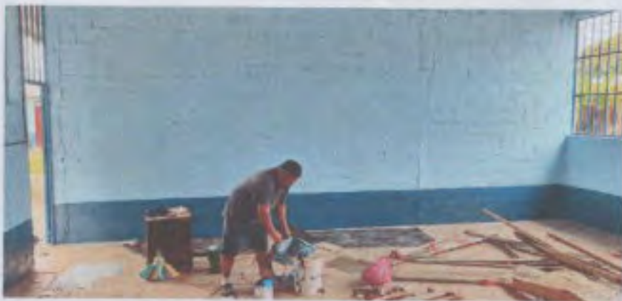
PINTURA EN MURO EXTERIOR E INTERIOR
