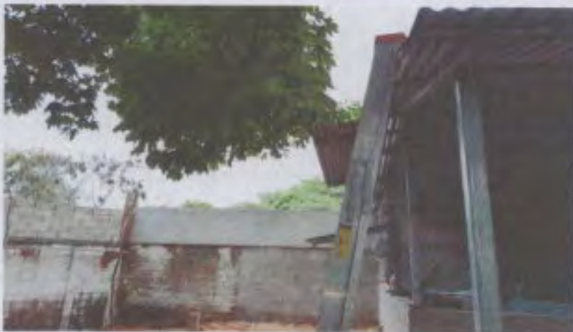
SUSTITUCIÓN DE LAMINA TROQUELADA ALUZINC CALIBRE 26
