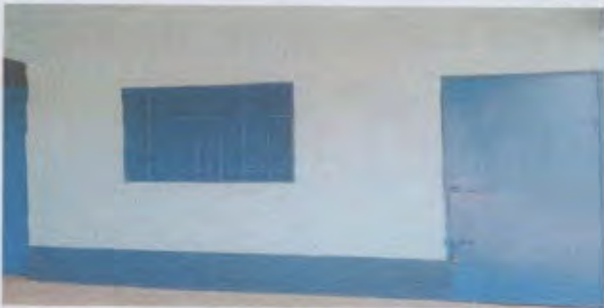
SUSTITUCIÓN DE PUERTAS
