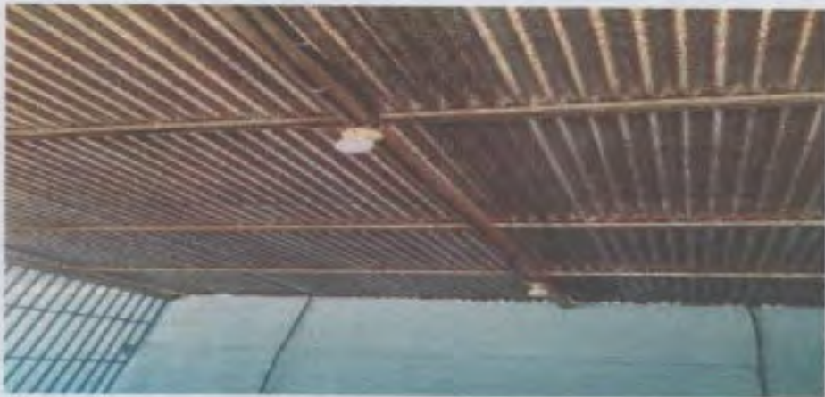
SUSTITUCIÓN DE DUCTO ELÉCTRICO + ACCESORIO
