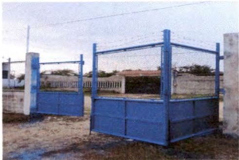
MANTENIMIENTO A PORTONES DE METAL
