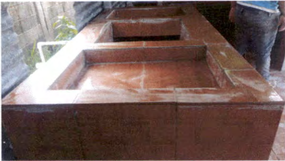
SUSTITUCIÓN DE PILA DE DOS LAVADEROS
