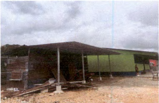
SUSTITUCIÓN DE CUBIERTA DE LÁMINA POR LÁMINA TROQUELADA ALUZINC CALIBRE 26
