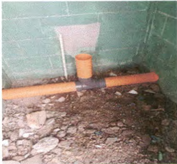
SUSTITUCION DE TUBERIA PVC LINEA PRINCIPAL AGUAS NEGRAS
