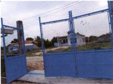
MANTENIMIENTO A PORTONES DE METAL
