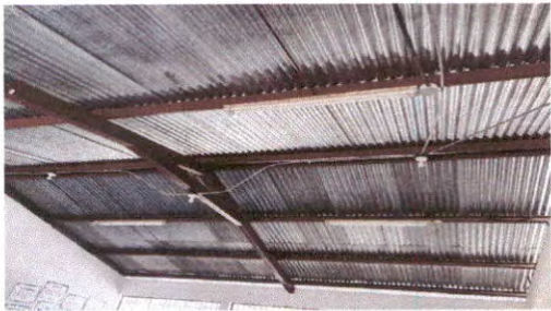
SUSTITUCIÓN DE DUCTO ELECTRICO MAS ACCESORIOS
