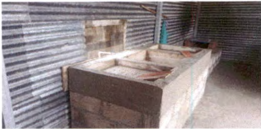
SUSTITUCIÓN DE PILA DE DOS LAVADEROS
