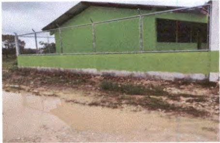
APLICACIÓN DE PINTURA EN MURO EXTERIOR E INTERIOS
