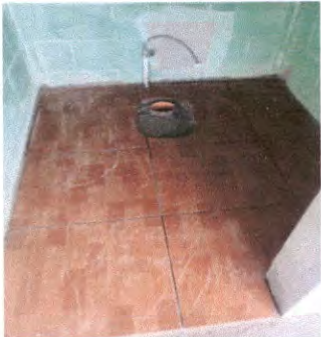
SUSTITUCIÓN DE TORTA DE CEMENTO
