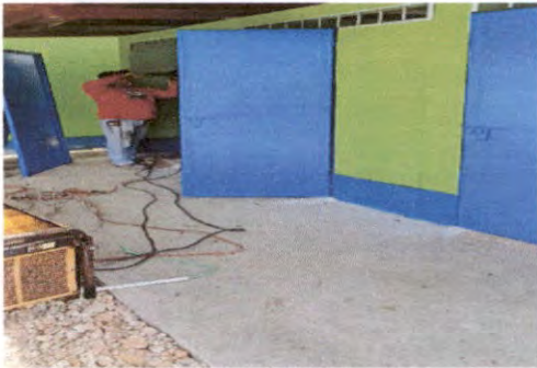
SUSTITUCIÓN DE TORTA DE CEMENTO
