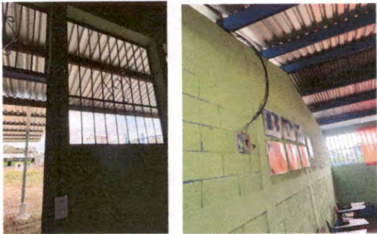
SUSTITUCIÓN DE CABLEADO PRINCIPAL
