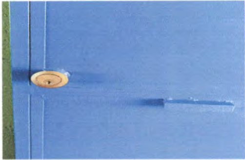
SUSTITUCIÓN DE CHAPA
