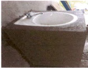
SUSTITUCIÓN DE LAVAMANOS
