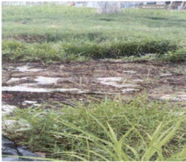
LIMPIEZA DE FOSA SEPTICA
