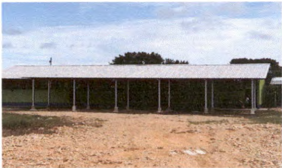
SUSTITUCIÓN DE SOPORTE DE METAL
