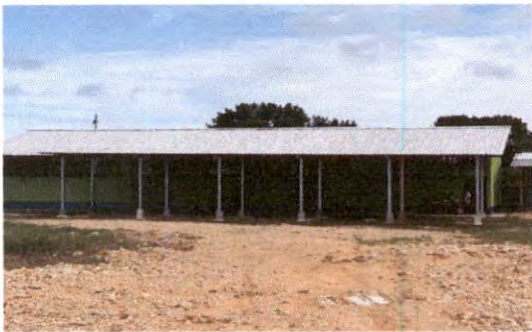
SUSTITUCIÓN DE LÁMINA POR LÁMINA TROQUELADA
