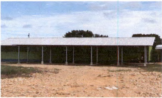
SUSTITUCIÓN DE COSTANERA
