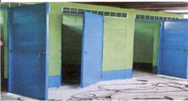
SUSTITUCIÓN DE PUERTA EN SERVICIO SANITARIO
