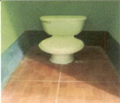
SUSTITUCIÓN DE INODORO
