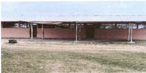
SUSTITUCIÓN DE CHAPA
