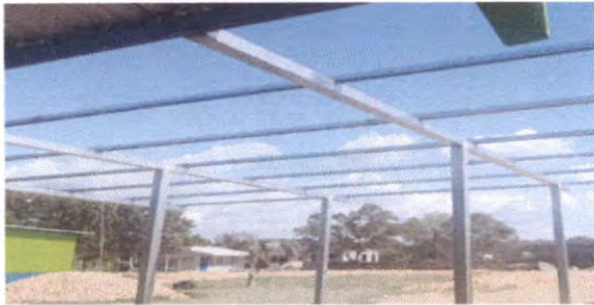
SUSTITUCIÓN DE SOPORTE DE METAL
