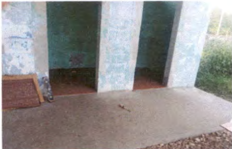
SUSTITUCIÓN DE TORTA DE CEMENTO
