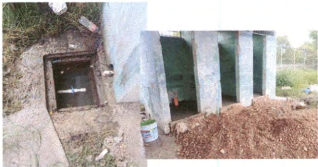
LIMPIEZA DE FOSA SEPTICA
