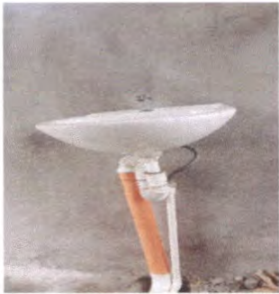
SUSTITUCIÓN DE LAVAMANOS
