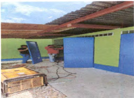
SUSTITUCIÓN DE PUERTA EN SERVICIO SANITARIO
