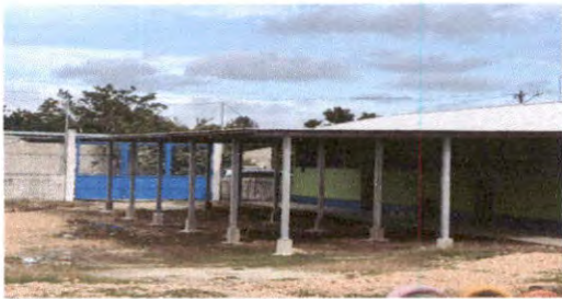
SUSTITUCIÓN DE LÁMINA POR LÁMINA TROQUELADA
