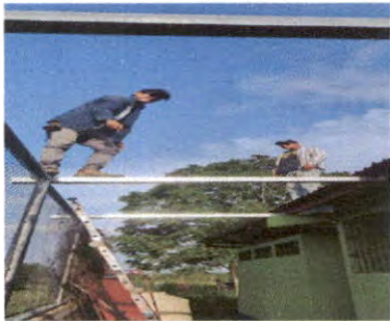
SUSTITUCIÓN DE COSTANERA
