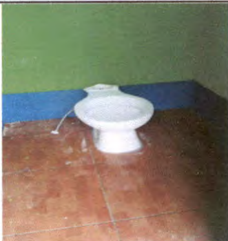
SUSTITUCIÓN DE INODORO
