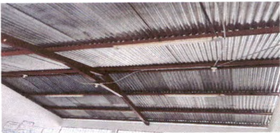
SUSTITUCIÓN DE CABLEADO PRINCIPAL
