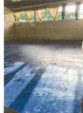
SUSTITUCION DE PISO DE CEMENTO
