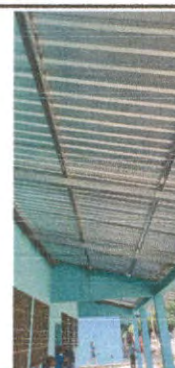
SUSTITUCION DE ELEMENTOS DE FIJACION
