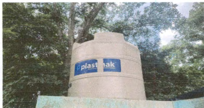
SUSTITUCION DE DEPOSITO DE AGUA 1,700 LT
