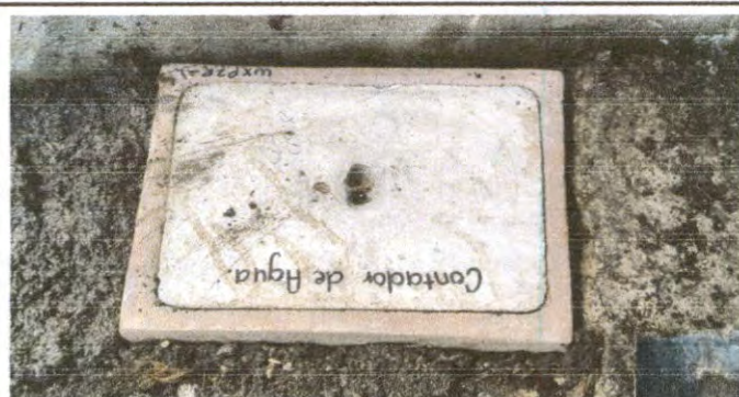
SUSTITUCION DE LLAVE DE CHEQUE Y CAJA DE CONTADOR
