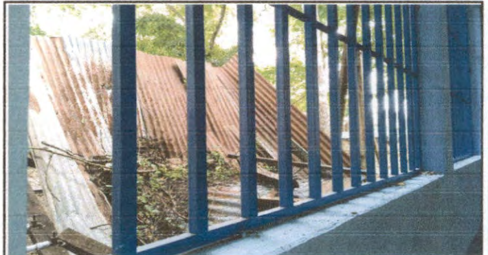
SUSTITUCION DE BALCONES DE METAL
