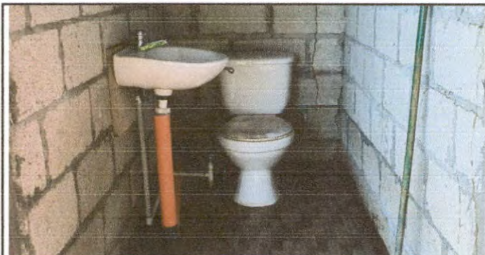
SUSTITUCION DE LAVAMANOS
