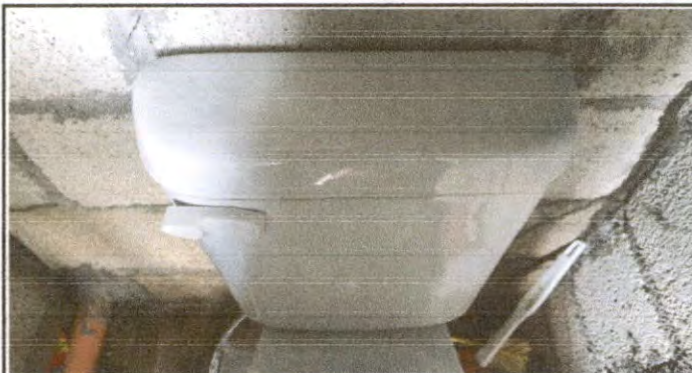
SUSTITUCION DE ACCESORIOS DE INODORO
