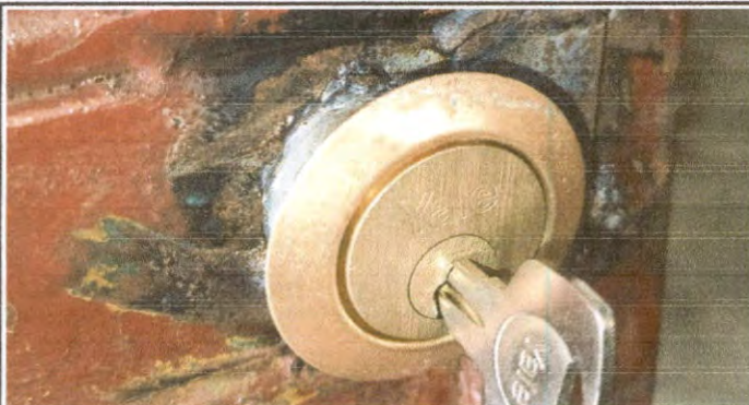
SUSTITUCION DE CHAPA
