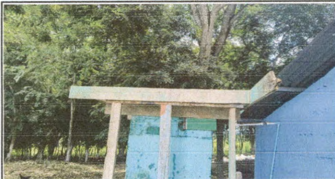
SUSTITUCION DE DEPOSITO DE AGUA 1,700 LT
