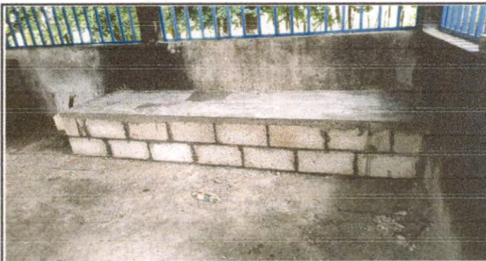
SUSTITUCION DE ESTUFA RURAL
