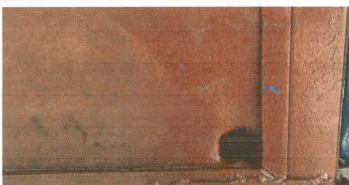
SUSTITUCION DE CHAPA
