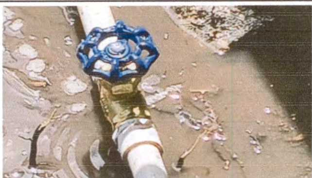
SUSTITUCION DE LLAVE DE CHEQUE Y CAJA DE CONTADOR
