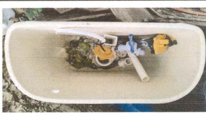
SUSTITUCION DE ACCESORIOS DE INODORO
