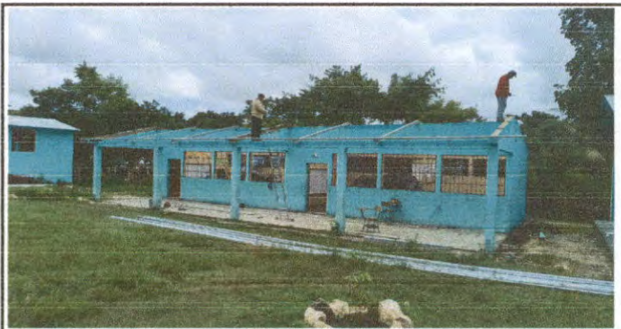
SUSTITUCION DE ESTRUCTURA SOPORTE DE MADERA POR METAL
