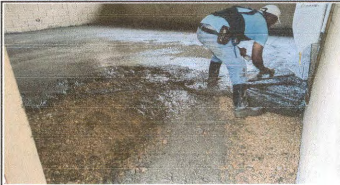
SUSTITUCION DE PISO DE CEMENTO
