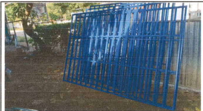
SUSTITUCION DE BALCONES DE METAL
