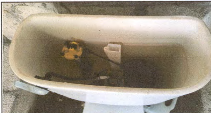
SUSTITUCION DE ACCESORIOS DE INODORO
