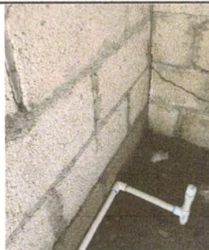
SUSTITUCION DE LAVAMANOS
