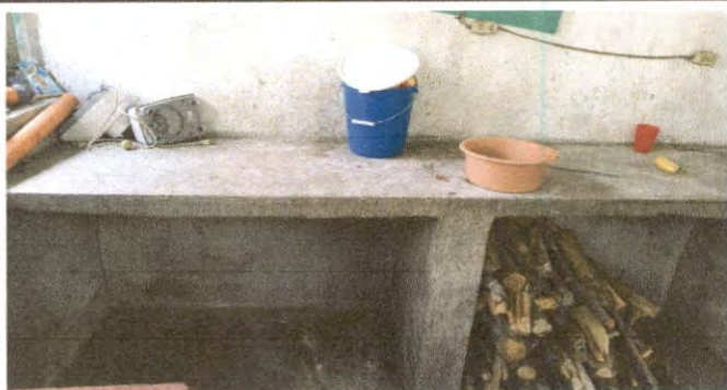
REPARACION DE AZULEJOS EN MUEBLES DE COCINA
