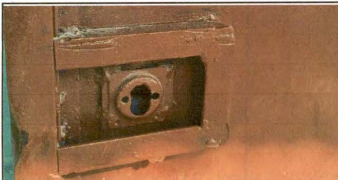
SUSTITUCION DE CHAPA
