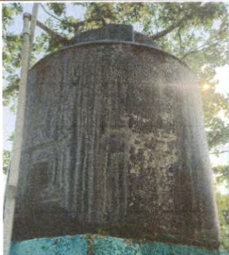
SUSTITUCION DE DEPOSITO DE AGUA 1,700 LT
