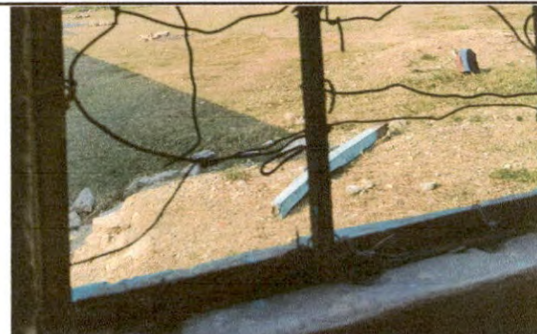
SUSTITUCION DE BALCONES DE METAL
