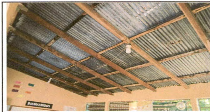
SUSTITUCION DE ELEMENTOS DE FIJACION
