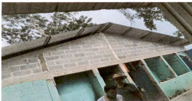
Foto 7: Sustitución de Techo
