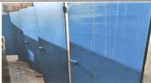
Foto 1: Sustitución de Puertas de Baños
