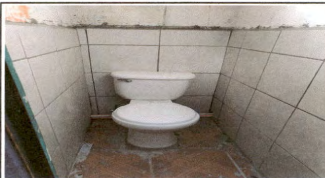
Foto 8: Sustitución de tuberías y llaves
