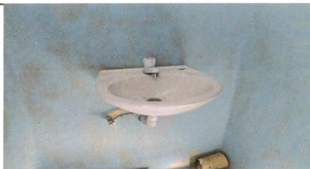
Foto 3: Sustitución de lavamanos
