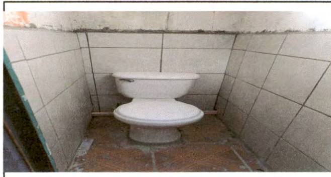
Foto 2: Sustitución de tazas de baños
