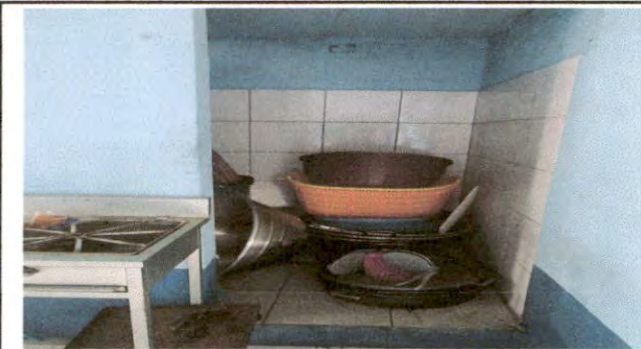
Foto 10. Sustitución de Azulejos de cocina
