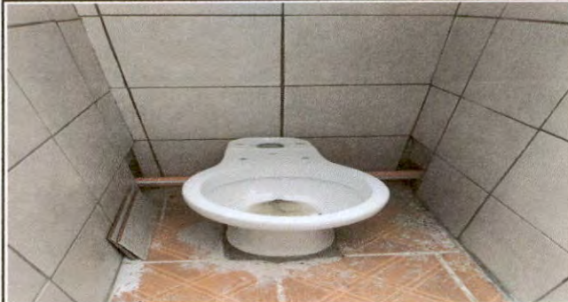
Foto 2: Sustitución de tazas de baños
