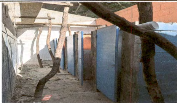
Foto1: Sustitución de Puertas de Baños
