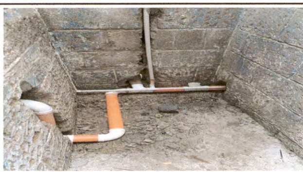
Foto 2: Sustrucción de tuberías y llaves
