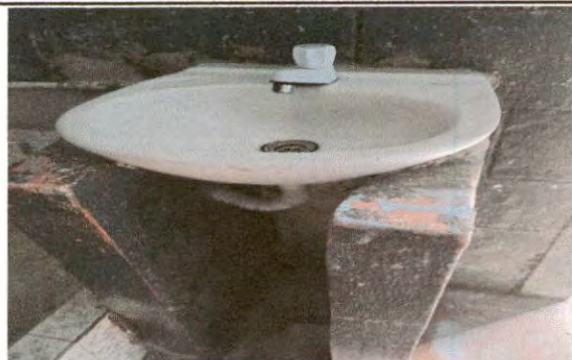
Foto 3: Sustitución de lavamanos
