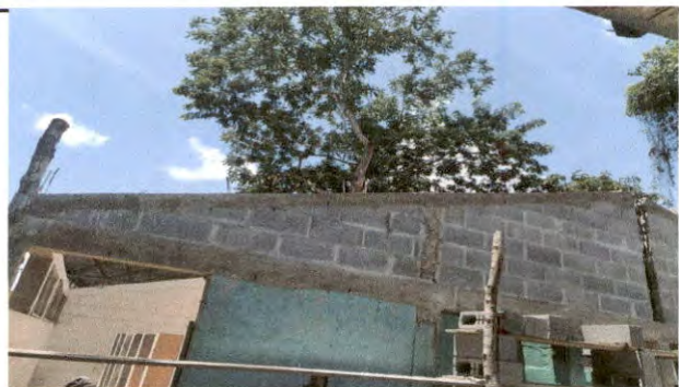
Foto 7: Sustrucción de Techo
