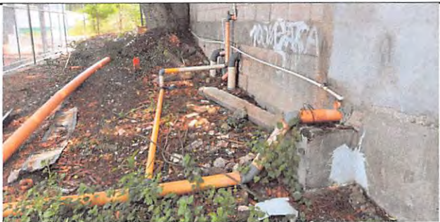
Foto 15: SUSTITUCION DE DE TUBERIA PVC DE AGUAS NEGRAS
