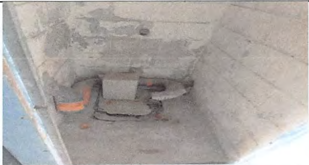
Foto 11: Instalacion de tuberia PVC
