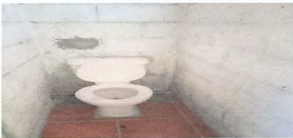
Foto 9: SUSTITUCION DE INODOROS
