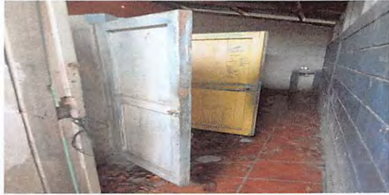
Foto 10: SUSTITUCIÓN DE PUERTASS EN SERVICIOS SANITARIOS
