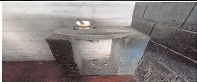
Foto 8: SUSTITUCIÓN DE LAVAMANOS
