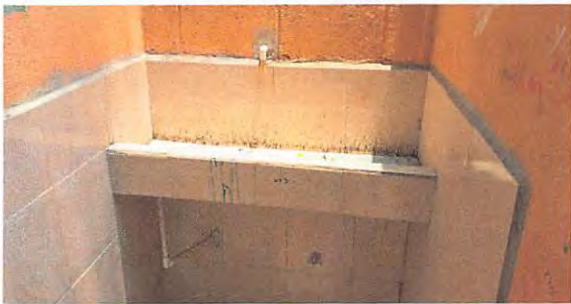
FOTO 1: SUSTITUCION DE AZULEJOS
