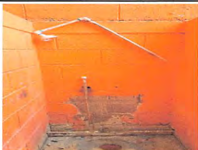
Foto 14: SUSTITUCIÓN DE MEZCLADORAS PARA DUCHAS
