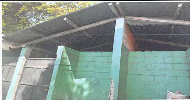
Foto 12: SUSTITUCIÓN DE ESTRUCTURA DE SOPORTE DE MADERA POR METAL
