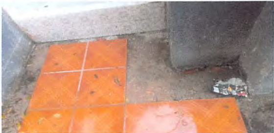
Foto 16: SUSTITUCIÓN DE PISO CERAMICO
