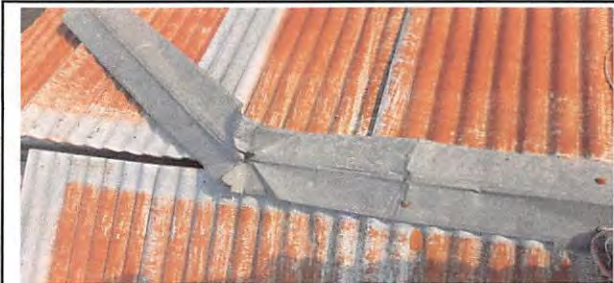
Foto 13: SUSTITUCION DE CANALES DE METAL
