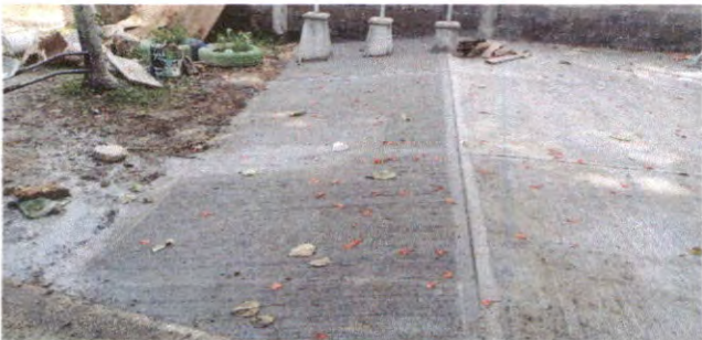
SUSTITUCIÓN DE TORTA DE CEMENTO, POR TORTA DE CEMENTO
