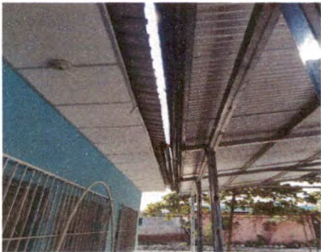
SUSTITUCIÓN DE DUCTO MAS ACCESORIOS
