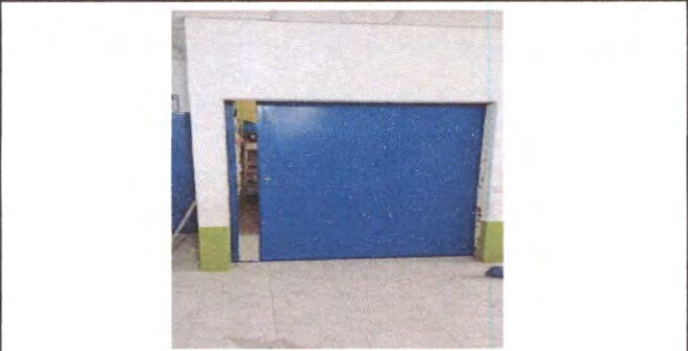
SUSTITUCIÓN DE PUERTAS
