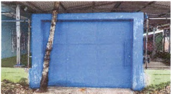
SUSTITUCIÓN DE PORTÓN DE METAL
