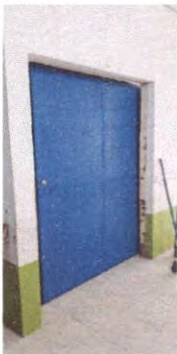
MANTENIMIENTO A ESTRUCTURA
