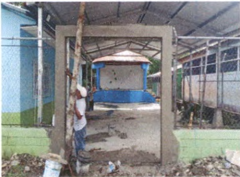
SUSTITUCIÓN DE PORTÓN DE METAL
