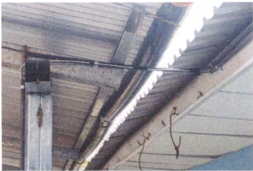
SUSTITUCIÓN DE CANAL
