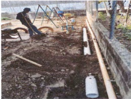
SUSTITUCIÓN DE TUBERIA PVC LINEA PRINCIPAL AGUAS NEGRAS
