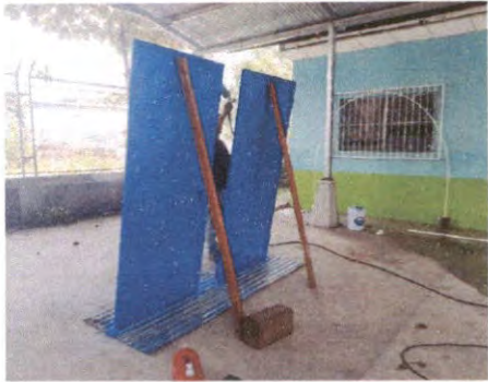
MANTENIMIENTO A ESTRUCTURA
