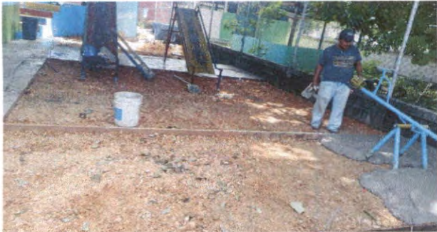
SUSTITUCIÓN DE TORTA DE CEMENTO, POR TORTA DE CEMENTO
