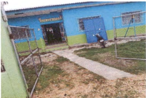
REPARACION DE TUBO HG Y MAYA GALVNIZADA
