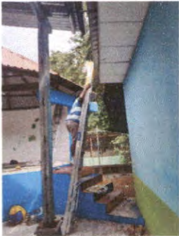
SUSTITUCIÓN DE DUCTO MAS ACCESORIOS
