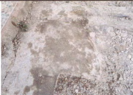
SUSTITUCIÓN DE TORTA DE CONCRERTO
