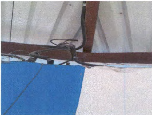
SUSTITUCIÓN DE DUCTO MAS ACCESORIOS
