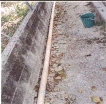
SUSTITUCIÓN DE TUBO PVC LINEA PRINCIPAL AGUAS NEGRAS
