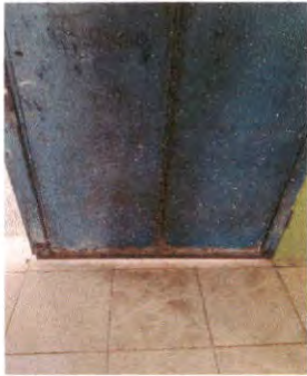
SUSTITUCIÓN DE PUERTA
