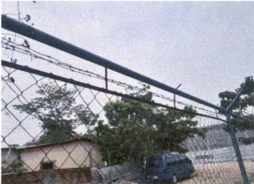
REPARACIÓN DE CERCO DE ALAMBRE DE PUA
