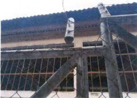
REPARACIÓN DE TUBO HG Y MALLA GALVANIZADA
