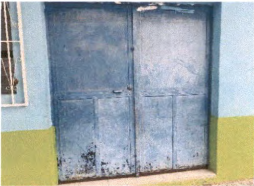
MANTENIMIENTO A ESTRUCTURA DE METAL
