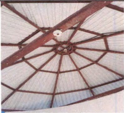
SUSTITUCIÓN DE LAMPARAS TIPO LED
