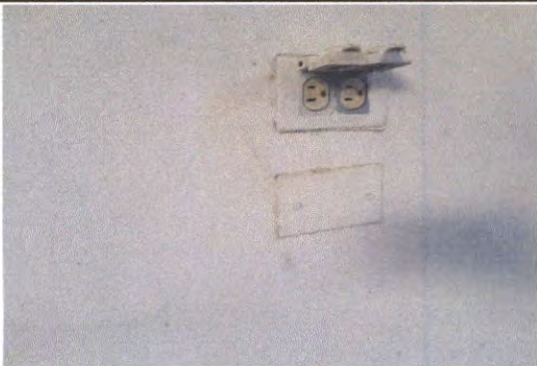
SUSTITUCIÓN DE TOMACORRIENTES DOBLE
