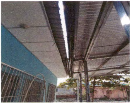
SUSTITUCIÓN DE CANAL DE METAL
