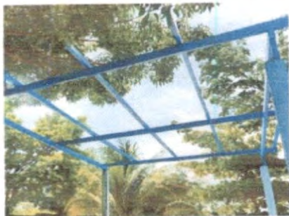
Mantenimiento a estructura portante de metal.
