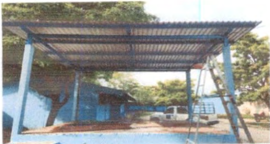
Sustitución de lámina, por lamina troquelada de aluzinc calibre 26. Desinstalación de lámina Existente.
