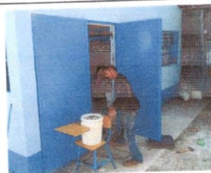
Sustitución de portón de metal.
