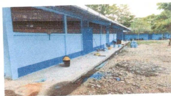
Pintura en muros exteriores e interiores.
