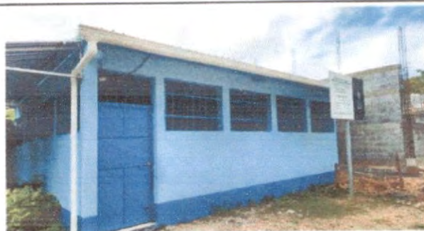
Sustitución de canal de metal.
