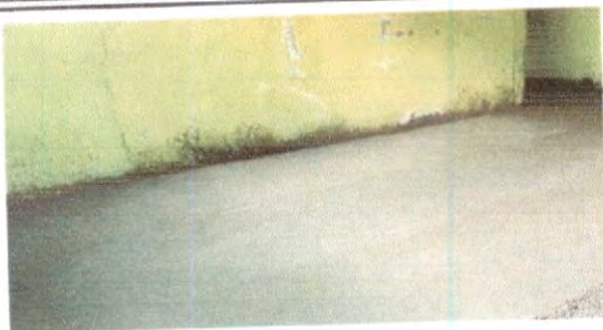
Sustitución de piso de torta de concreto.
