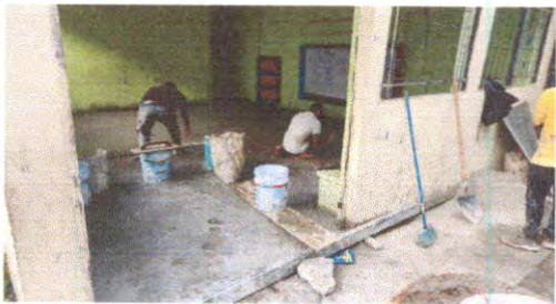
Sustitución de piso de torta de concreto.
