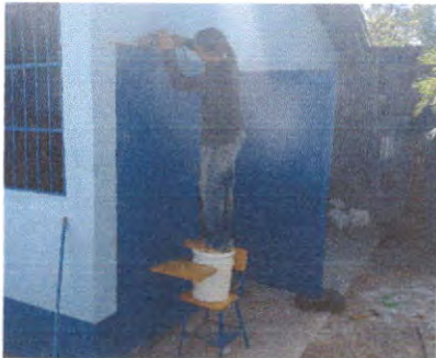
Sustitución de portón de metal.
