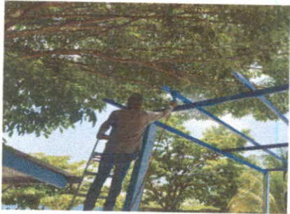
Mantenimiento a estructura portante de metal.
