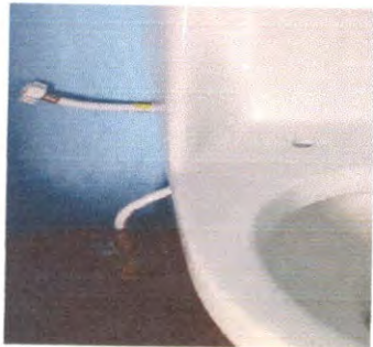
Sustitución de accesorios (contrallaves
