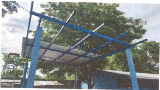
Sustitución de lámina, por lamina troquelada de aluzinc calibre 26. Desinstalación de lámina Existente.
