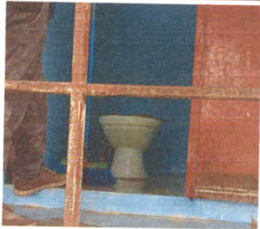
Sustitución de Inodoros.
