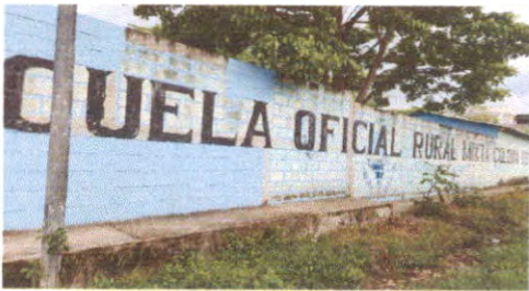
Pintura en muros exteriores e interiores.
