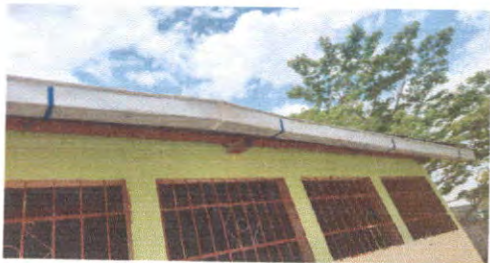
Sustitución de canal de metal.
