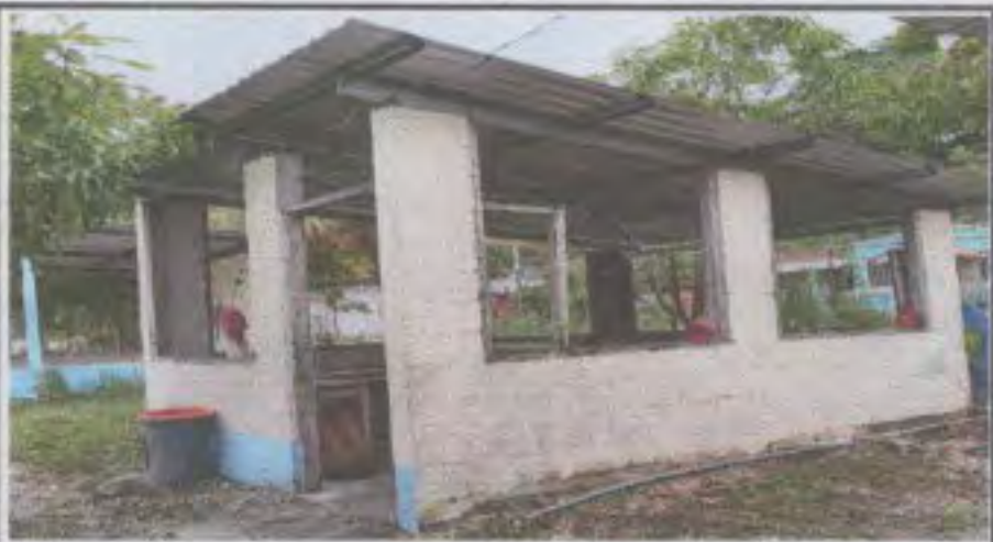
Foto 4: Por medio de esta fotografía de perfil queda evidenciada la instalación de la lámina troquelada aluzinc calibre 26 en la respectiva cocina.
