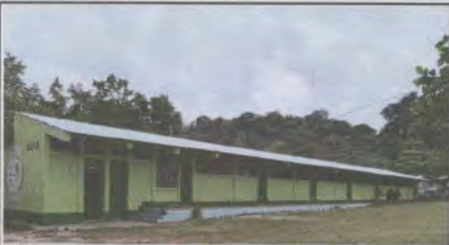
Foto 2: En esta fotografía se puede observar como quedó instalada la lámina troquelada aluzinc calibre 26, en su totalidad en las aulas.
