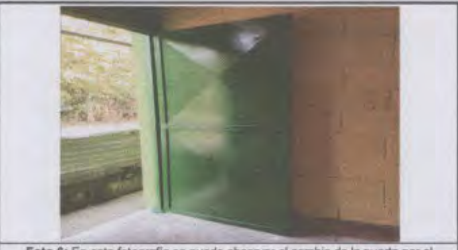
Foto 6: En esta fotografía se puede observar el cambio de la puerta por el mantenimiento de lijado, cepillado, lámina dañada y aplicación de la pintura que se hizo en la puerta, en la parte de atrás de la dirección.
