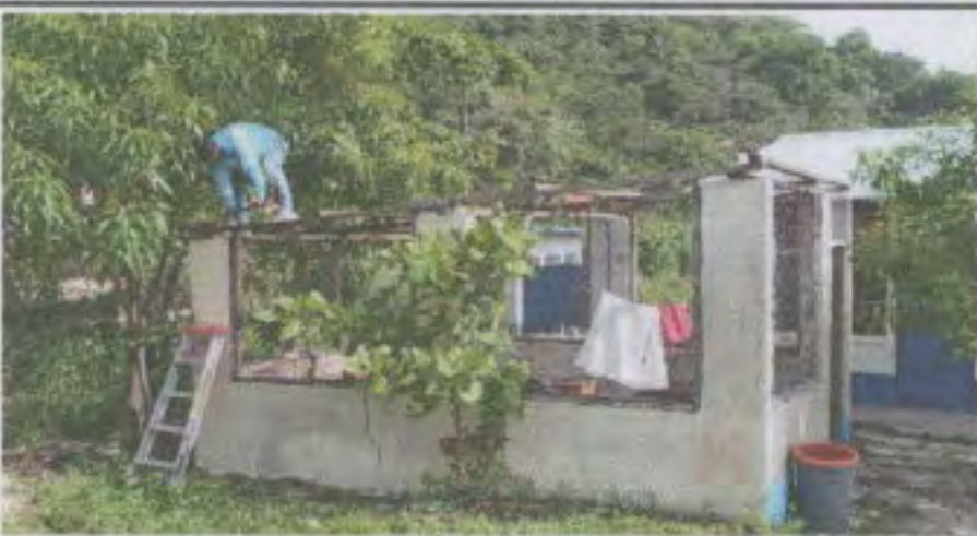
Foto 3: Realizando la desinstalación de la lámina actual de la cocina donde se preparan los alimentos escolares.
