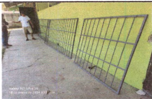
Foto 3: Renglon 5.6. Sustitución de balcones de metal en la parte de frontal y de atrás de las aulas del modulo 1
