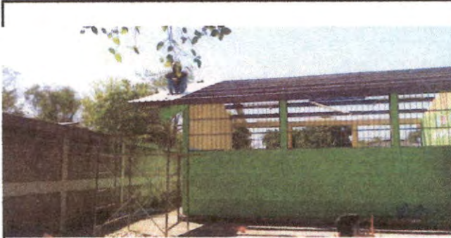
Foto 2: Renglon 1.1 Sustitución de lamina, por lamina troquelada aluzinc calibre 26 en el Modulo 1 de la Escuela
