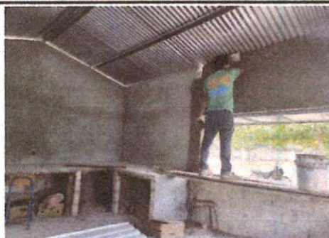
Foto 5: Renglon 21.2 Cernido en muro exterior e interior de la Cocina Escolar. Renglon 9. Pintura en exterior e interior de cocina
