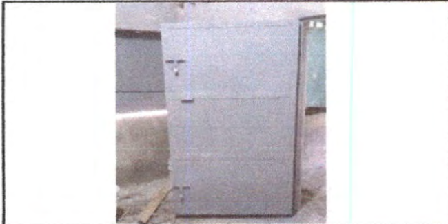
Foto: 7 Renglon 4. Sustitución de Puerta de metal.
