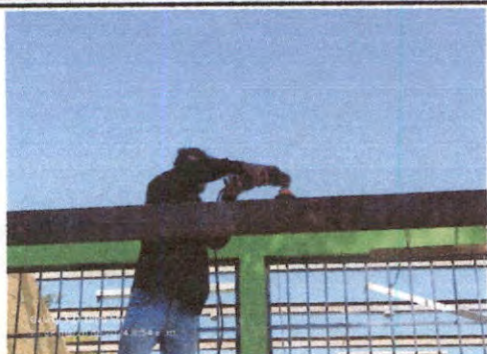
Foto 1: Renglon 2.2. Mantenimiento a estructura de soporte de metal en modulo 1 de la Escuela
