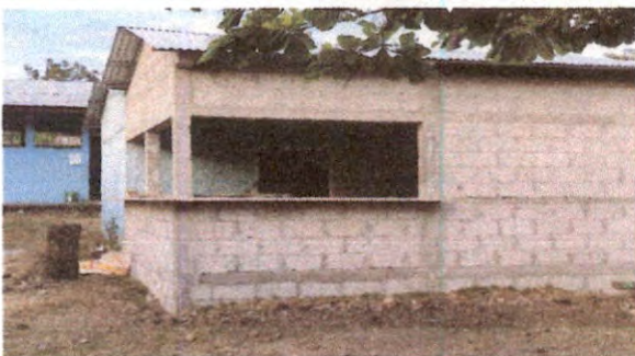
Foto 5: Renglon 21.2 Cernido en muro exterior e interior de la Cocina Escolar, Renglon 19.1 Fabricación e instalación de ventanas en cocina. Renglon 9. Pintura en exterior e interior de cocina
