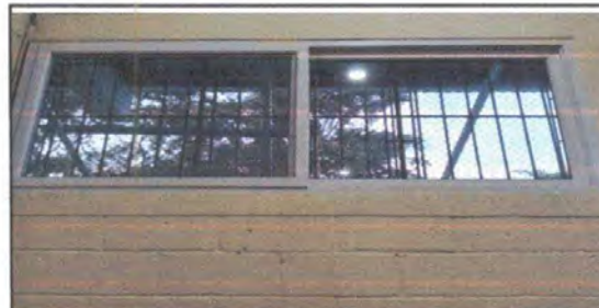
Foto 12: SUSTITUCIÓN DE ESTRUCTURA DE METAL DE VENTANA.
