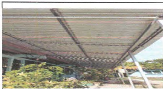
Foto 10: SUSTITUCIÓN DE LÁMINA POR LÁMINA TROQUELADA ALUZINC CALIBRE 26. EN EL CORREDOR.
