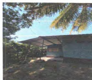
Foto 4: SUSTITUCIÓN DE LÁMINA POR LÁMINA TROQUELADA, ALUZINC CALIBRE 26. EN LOS SERVICIOS SANITARIOS.
