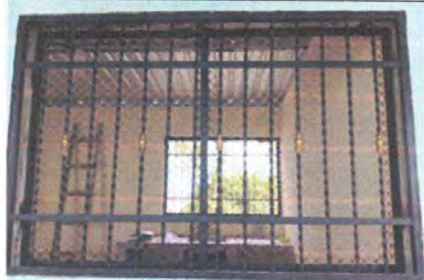
Foto1: SUSTITUCIÓN DE BALCÓN DE METAL.
