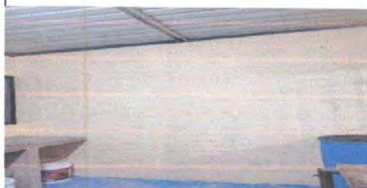
Foto 14: PINTURA INTERIOR DE AULAS, COCINA Y BAÑOS
