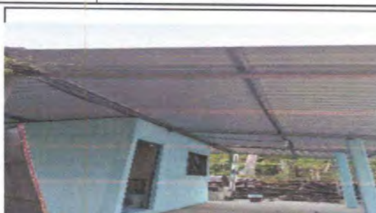
Foto 8: SUSTITUCIÓN DE LÁMINA POR LÁMINA TROQUELADA ALUZINC, CALIBRE 26. EN LA COCINA.
