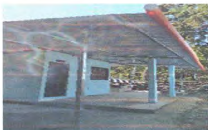
Foto 17. CANAL DE PVC 18 mts EN COCINA
