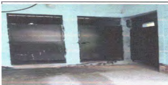
Foto 5: SUSTITUCIÓN DE PUERTA DE METAL EN SERVICIOS SANITARIOS.
