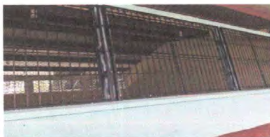
Foto 11: MANTENIMIENTO A BALCONES DE METAL.
