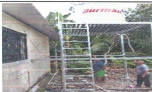
Foto 9: SUSTITUCIÓN DE DEPÓSITO PARA AGUA.
