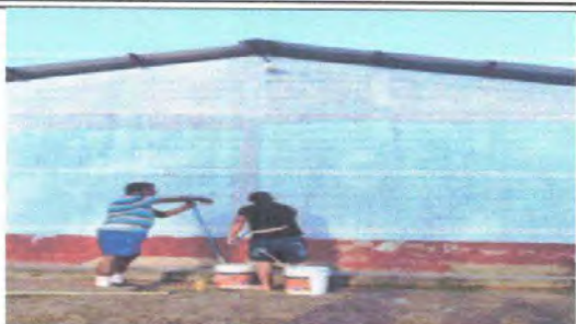
Foto 13. PINTURA INTERIOR EXTERIOR AULAS, COCINA Y BAÑOS
