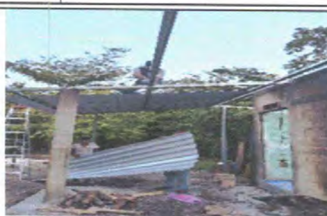
Foto 8: SUSTITUCIÓN DE LÁMINA POR LÁMINA TROQUELADA ALUZINC, CALIBRE 26. EN LA COCINA.
