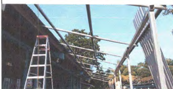
Foto 10: SUSTITUCIÓN DE LÁMINA POR LÁMINA TROQUELADA ALUZINC CALIBRE 26. EN EL CORREDOR.
