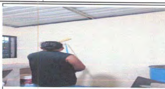
Foto 14: PINTURA INTERIOR DE AULAS, COCINA Y BAÑOS
