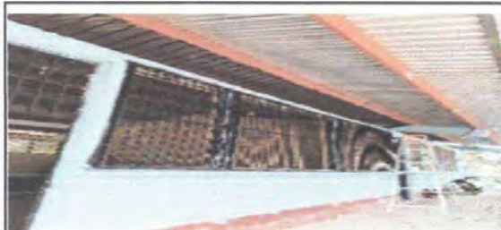
Foto 11: MANTENIMIENTO A BALCONES DE METAL.
