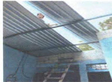
Foto 4: SUSTITUCIÓN DE LÁMINA POR LÁMINA TROQUELADA, ALUZINC CALIBRE 26. EN LOS SERVICIOS SANITARIOS.
