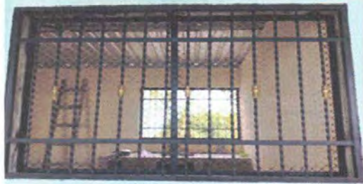
Foto 1: SUSTITUCIÓN DE BALCÓN DE METAL.
