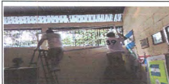
Foto 12: SUSTITUCIÓN DE ESTRUCTURA DE METAL DE VENTANA.
