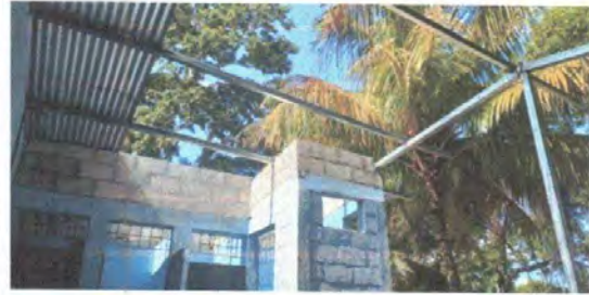
Foto 20: AMPLIACION ALTURA DE BAÑO
