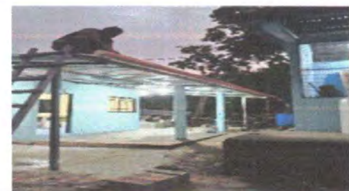
Foto 17. Canal de PVC 18 mts en Cocina
