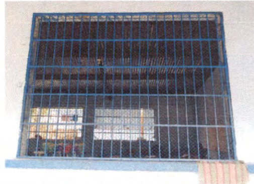
Foto 8: Sustitución de ventanas de madera por metal con malla
