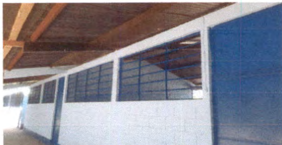
Fotos 13: Mantenimientos a balcones de metal
