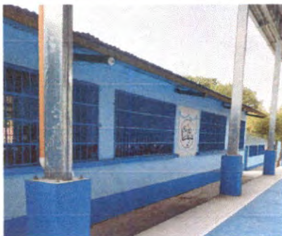
Foto 9: Sustitución de ventanas de madera por metal con malla
