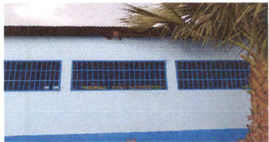
Foto 10: Sustitución de ventanas de madera por metal con malla
