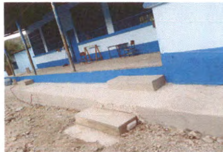
Foto 4: Reparación de banquetas de concreto
