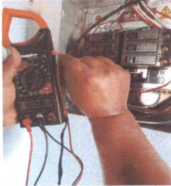
Foto 19: Sustitución de tableros de flipones
