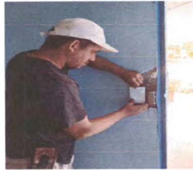
Foto 20: Sustitución de interruptores dobles
