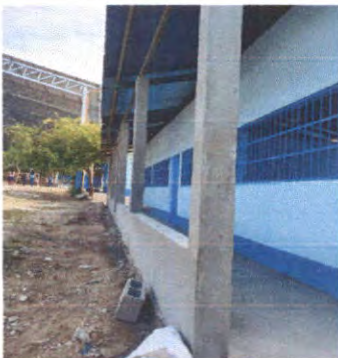
Foto 5: Reparación de muro de contención
