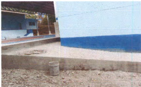
Foto 3: Reparación de banquetas de concreto
