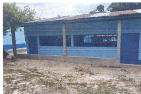
Foto 6: Reparación de muro de contención
