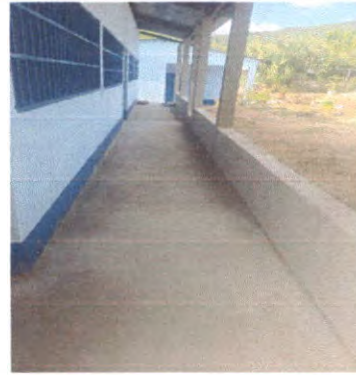
Foto 2: Reparación de piso de torta de concreto
