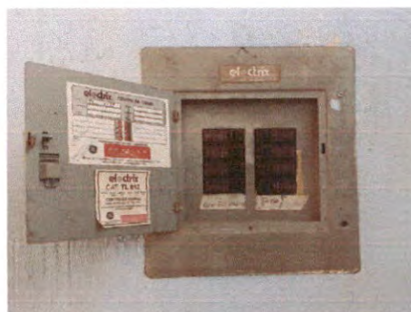
Foto 16: Sustitución de flipones
