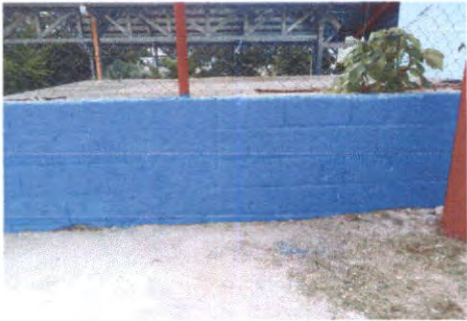
Foto 1: Reparación de muro perimetral de block.
