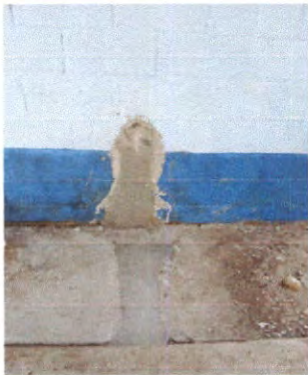
Foto 7: Sellado de grietas y fisuras en muros
