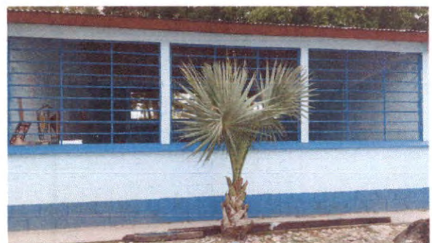
Foto 12: Mantenimiento a balcones de metal
