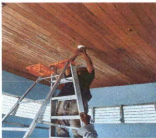
Foto 17: Reparación de lámparas
