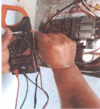
Foto 19: Sustitución de tableros de flipones
