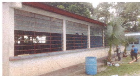
Foto 12: Mantenimiento a balcones de metal
