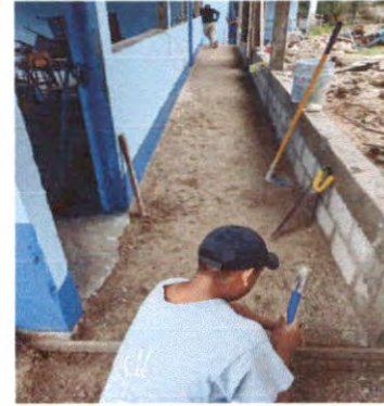
Foto 2: Reparación de piso de torta de concreto
