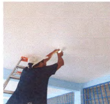
Foto 18 Reparación de lámparas
