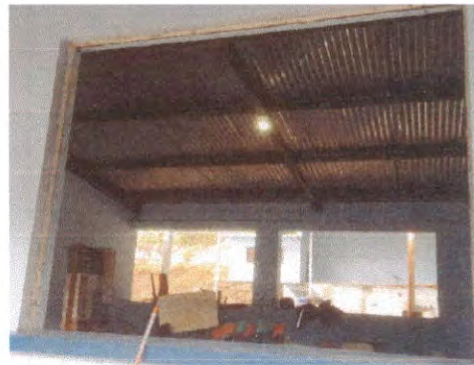
Foto 8: Sustitución de ventanas de madera por metal con malla
