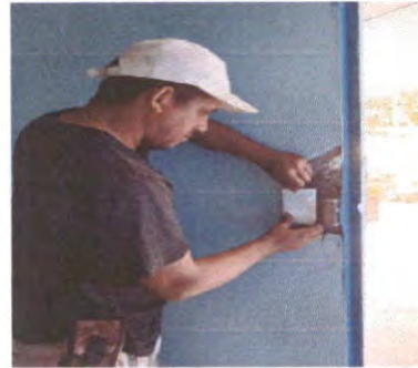
Foto 20: Sustitución de interruptores dobles
