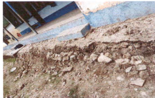
Foto 4: Reparación de banquetas de concreto
