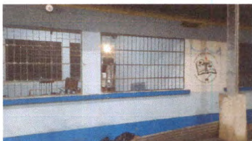
Foto 9: Sustitución de ventanas de madera por metal con malla
