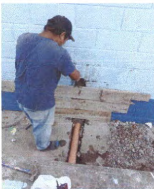
Foto 7: Sellado de grietas y fisuras en muros
