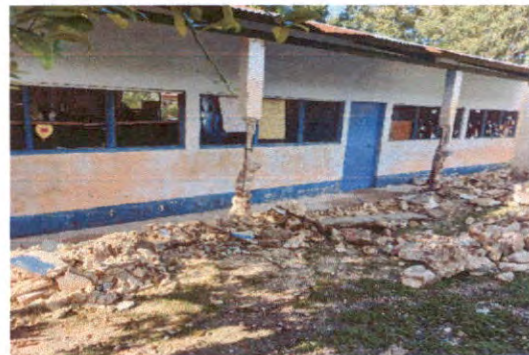
Foto 6: Reparación de muro de contención
