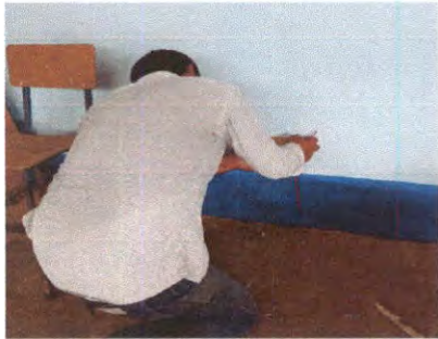
Foto 15: Sustitución de tomacorrientes dobles
