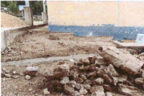
Foto 3: Reparación de banquetas de concreto
