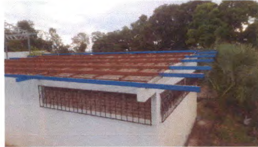
Foto 14: Sustitución de lámina, por lamina troquelada aluzinc calibre 26
