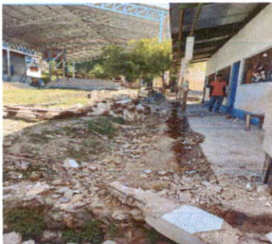
Foto 5: Reparación de muro de contención
