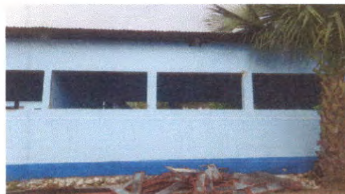
Foto 10: Sustitución de ventanas de madera por metal con malla
