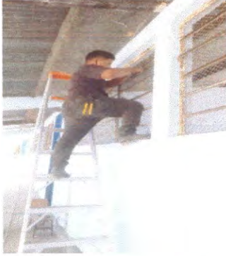
Fotos 13: Mantenimientos a balcones de metal
