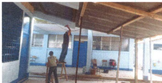
Foto 11: Sustitución de estructura de soporte de madera, por metal
