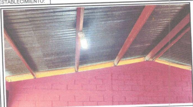
FOTO 7. Reparacion de sistema electrico
