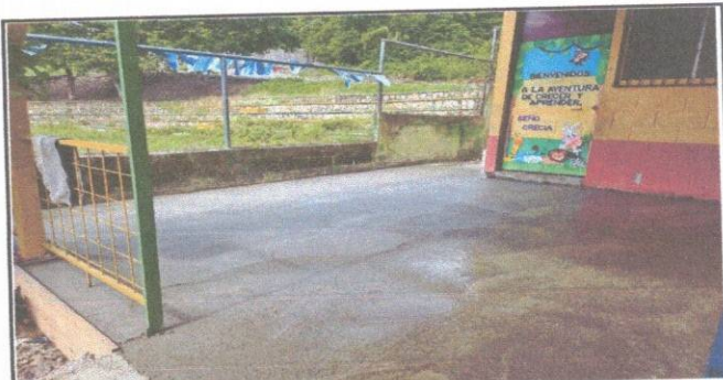
FOTO 6. Reparacion de plancha de concreto de patio
