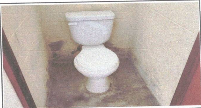
FOTO 4. Sustitucion de inodoro
