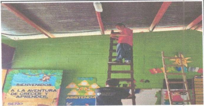
FOTO 7. Reparacion de sistema electrico
