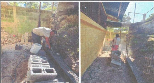
FOTO 2. Reparacion de cuneta de concreto
