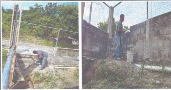
FOTO 5. Reparacion de muro perimetral de block
