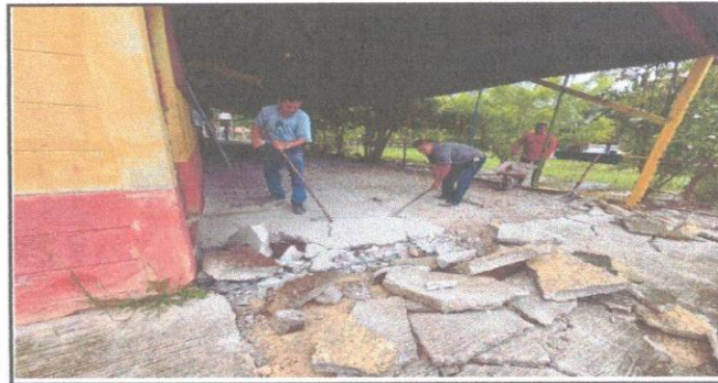
FOTO 6. Reparacion de plancha de concreto de patio
