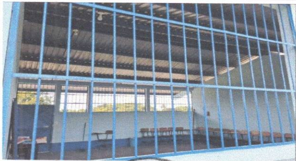
Foto 6: Mantenimiento a estructura de metal de ventanas
