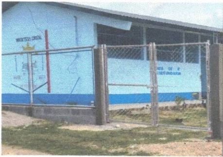
Foto 5: Portón / sustitución de porton de metal
