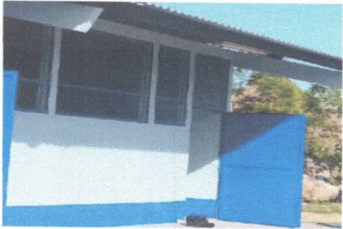
Foto1: Sustrucción de puertas/ Puertas de metal
