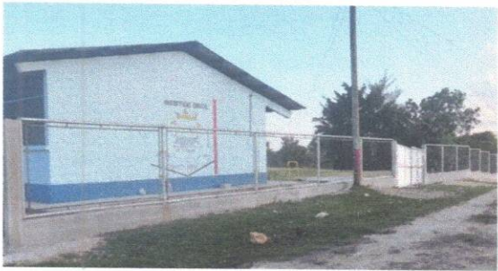
Foto 4: Muro perimetral / Reparaciones en muro perimetral
