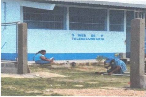
Foto 5: Portón / sustitución de porton de metal
