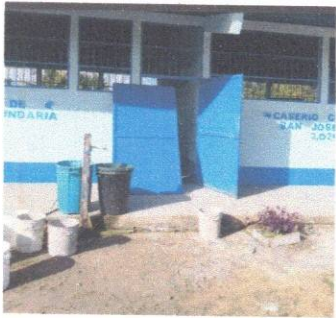
Foto1: Sustrución de puertas/ Puertas de metal
