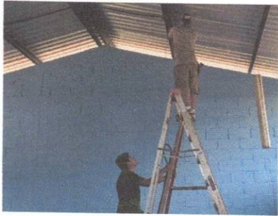
Foto 2: Reparación de sistema electrico
