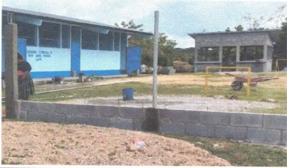
Foto 4: Muro perimetral / Reparaciones en muro perimetral
