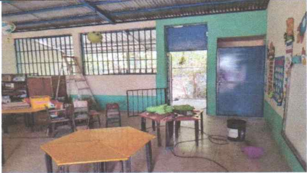
sustitucion de puerta de metal
