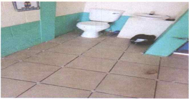
sustitución de taza de baño
