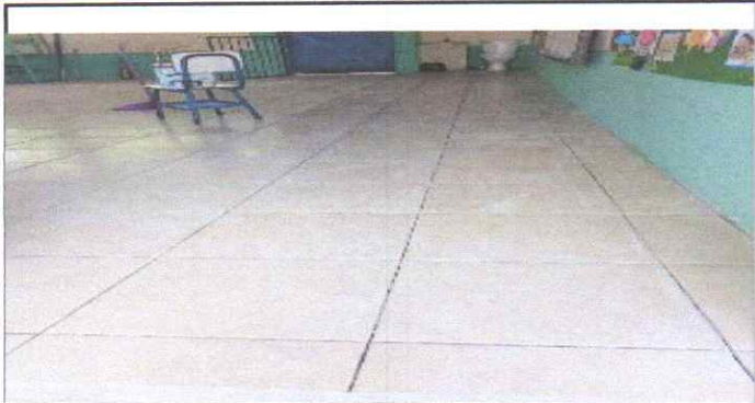
sustitucion de piso cerámico
