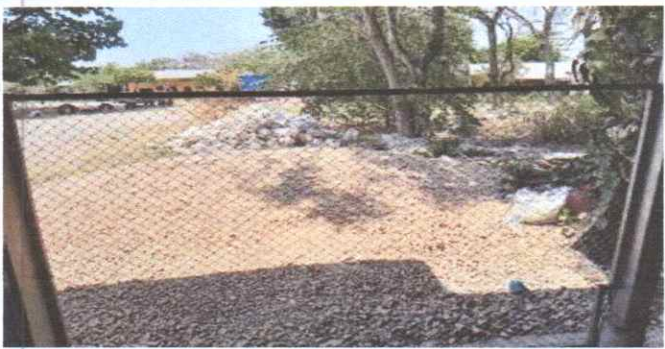
sustitución de malla galvanizada
