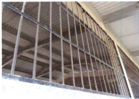
Foto1: Mantenimiento balcones de metal antes
