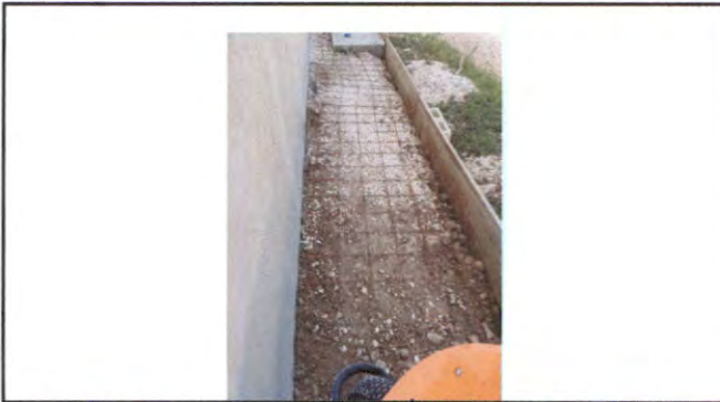
Foto 1: Reparación de banqueta de concreto
