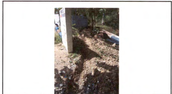
Foto 4: Instalación de tubería PVC antes
