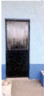
Fabricación e instalación de puerta en cocina
