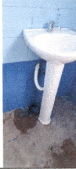
Sustitución de mezcladora lavamanos
