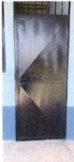
Mantenimiento a estructura de puertas
