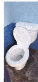
Sustitución de inodoro
