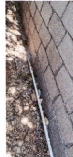
Instalación de tubería principal
