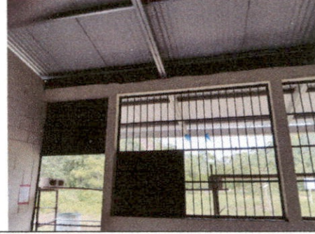
Repello de muro
