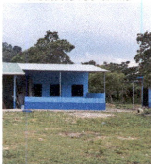
Sustitución de lámina
