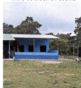
Muro de block en cocina
