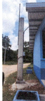
Instalación de cometa
