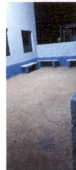
Reparación de torta de cemento
