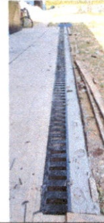
Fabricación e instalación de rejilla para cuneta
