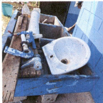
Sustitución de mezcladora lavamanos
