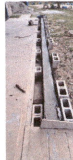
Fabricación e instalación de rejilla para cuneta
