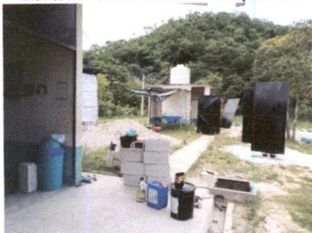
Mantenimiento a estructura de puertas
