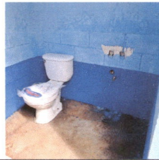
Sustitución de inodoro
