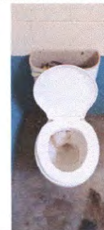
Sustitución de inodoro
