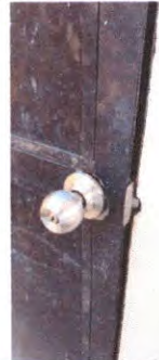
Sustitución de chapas
