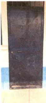
Mantenimiento a estructura de puerta
