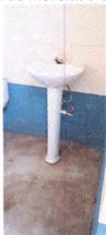
Sustitución de mezcladora lavamanos
