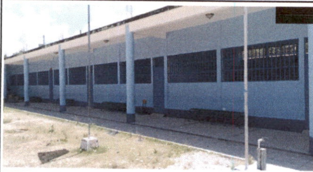
Foto1: Pintura aulas exterior
