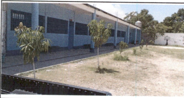
Foto 5: Pintura de aulas lado derecho
