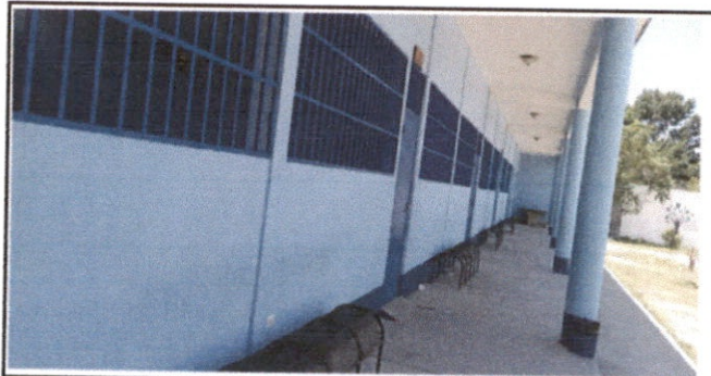
Foto 6: Pintura de aulas exterior
