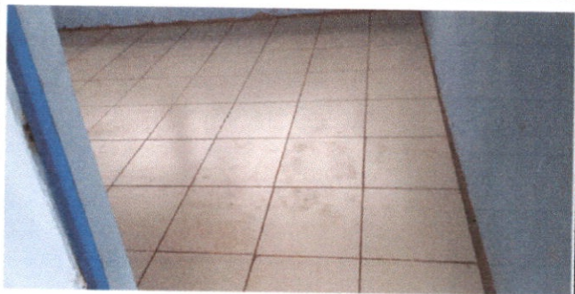
Foto 4: Colocación piso ceramico en la cocina
