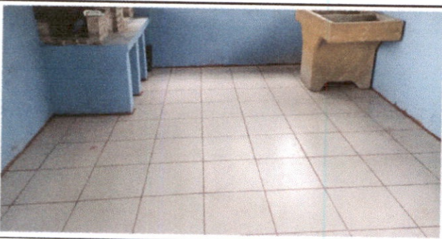
Foto 5: Colocación piso ceramico y polleton
