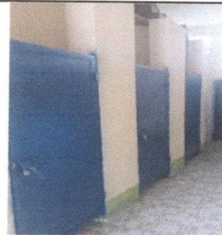
Foto 6: Avance de pintura puertas de los baños
