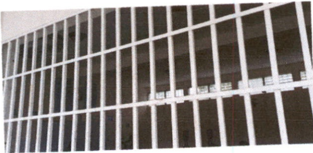
Foto 5: Trabajos de alijado de balcones
