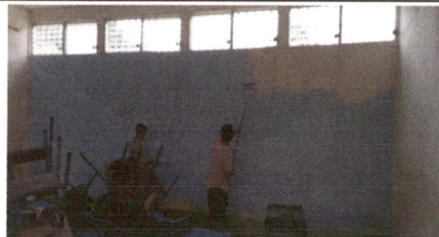
Foto 2: Pintando el interior de las aulas
