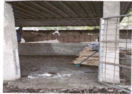
Foto 4: Trabajos en la cocina
