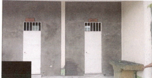
Foto 4: Reparación de pared agrietada
