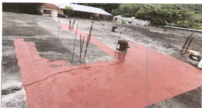
Foto 5: Trabajos de impermeabilización de losa
