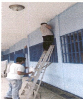
Foto1: Pintado las paredes externas
