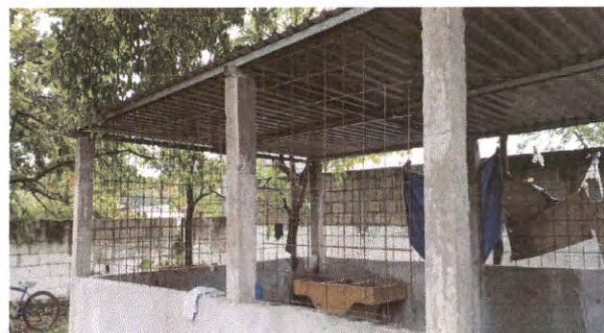
Foto 4: Colocación de balcones, área de cocina
