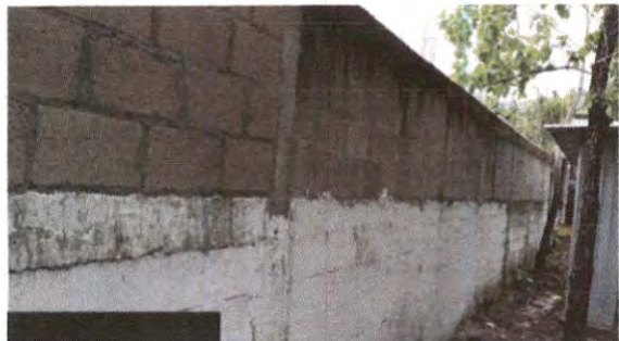
Foto1: Repello interno y externo
