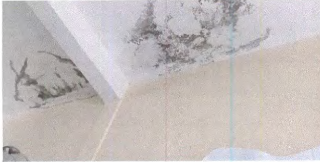
Foto1: Arreglo en el techo
