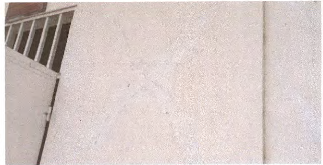
Foto 2: Repello en áreas dañadas
